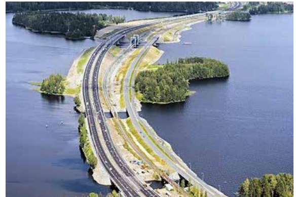
Kallansiltojen käytävässä kulkevat rinnakkain moottoritie, rautatie ja paikallinen maantie kevyen liikenteen erillisväylälineen.
