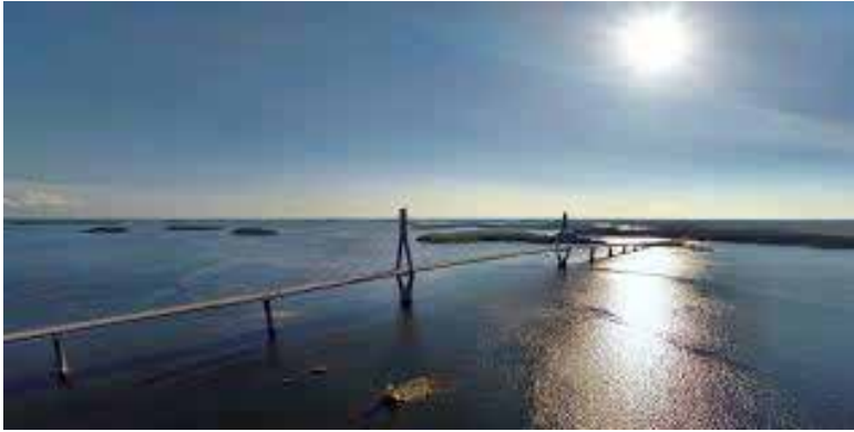
Raippaluodon silta on Suomen pisin.
