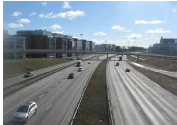
Isot kaupunkiautotiet vuorataan liikerakennuksilla. Firket pääsevät näkyville ja vierialueen haitat vähenevät. Kuva Kehä III:lta lentoaseman liittymästä itään.
