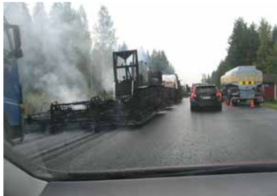
Uusiopäällystystä valtatie 3:lla kesällä 2016. Kolonnamalli antaa mahdollisuuden pitää toinen kaista auki.
