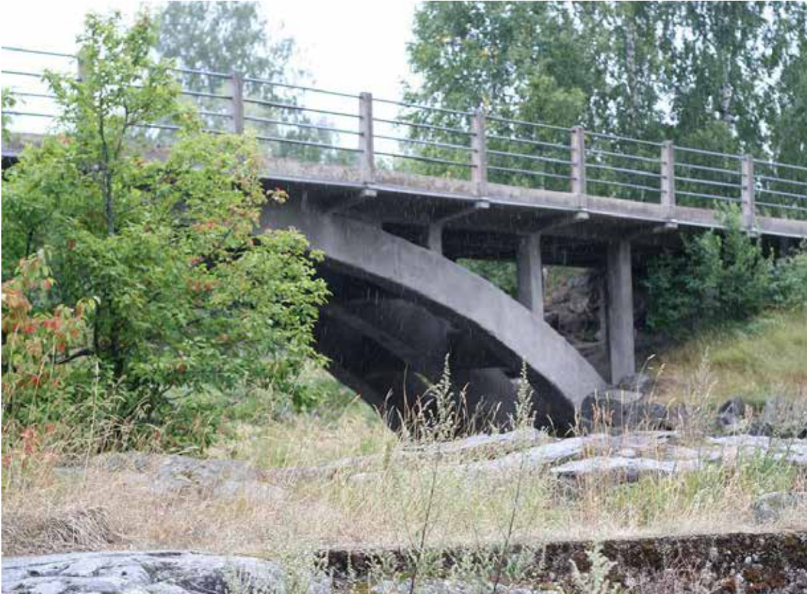
Vankkaa teräsbetonitekniikkaa – Jalmar Castrénin suunnittelema Tönnön silta vm 1911.
