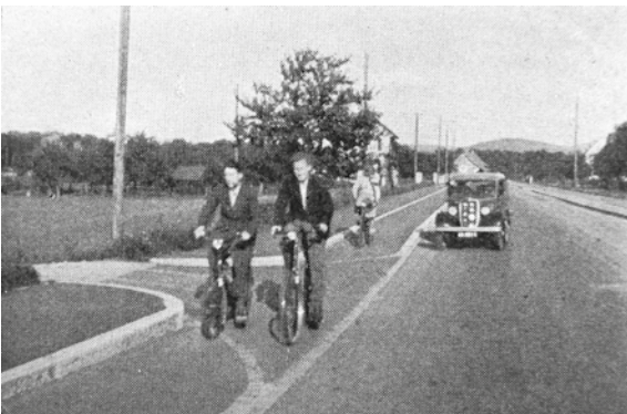
Ajorataa korkeammalle porrastettu pyörätie ja jalkakäytävä. Sveitsi.
