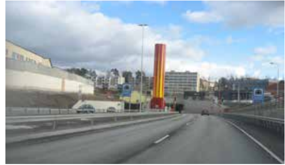
Läntistä suuaukkoa korostaa keltainen ilmanpoistopiippu eli kamiina.
