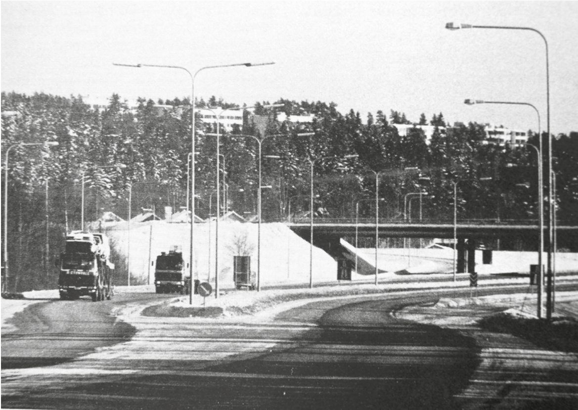
Ojoisen eritasoliittymä Hämeenlinnan moottoritien pohjoispäässä valmistui 1985.
