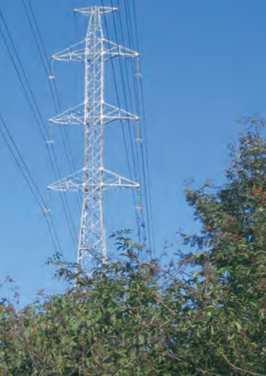
Harustamaton yksijalkainen vapaasti seisova pylväs
