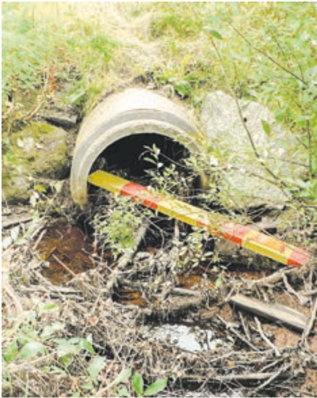
Uomaa kaventava betonirumpu kerää helposti vedessä ajelehtivaa kariketta ja jätemateriaalia.
