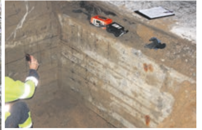
Vanhat maatuet ja mm. niiden raudoitukset tutkittiin tarkasti. Ne osoittautuivat kestäviksi uudellekin sillalle.
