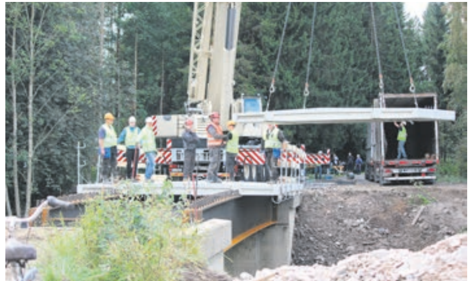
Sillan kansielementit löytävät paikkansa teräspalkkien päälle.
