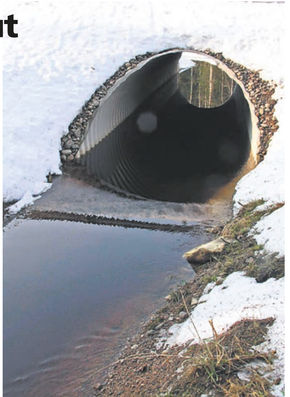
Palikkapuron teräsputkisilta (Saarijärvi) on ympäristöystävällisesti asennettu ylitysrakenne.
