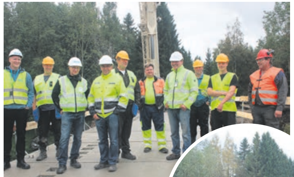
Silta-asennus on ammattilaisten tiimityötä.
