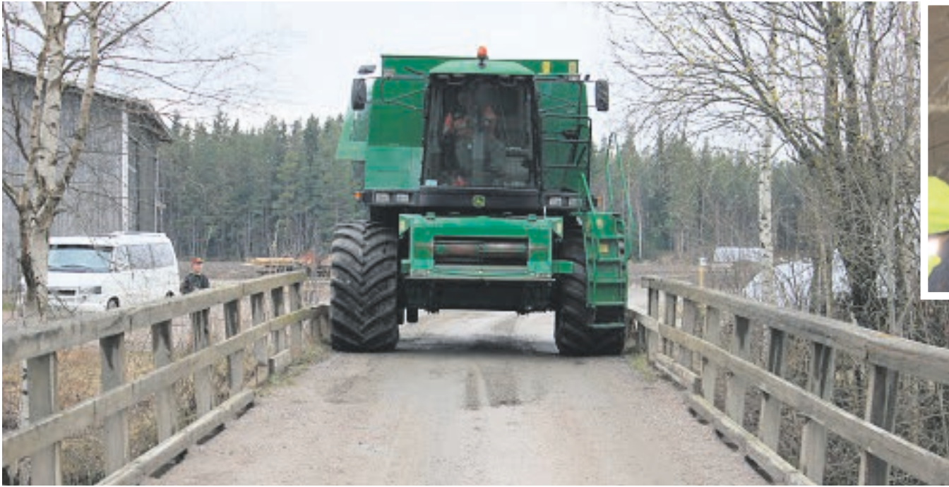
Vanha silta ei enää täyttänyt nykyajan vaatimuksia. Kansi ja kaiteet olivat huonot ja silta kapea.
