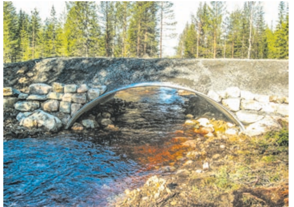
Uomaa kaventava betonirumpu kerää helposti vedessä ajelehtivaa kariketta ja jätemateriaalia.
