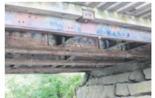
Nämä vanhoista kuorma-auton runko-osista kootut siltojen palkistot pitää korvata nykyajan vaatimukset täyttävillä rakenteilla.
