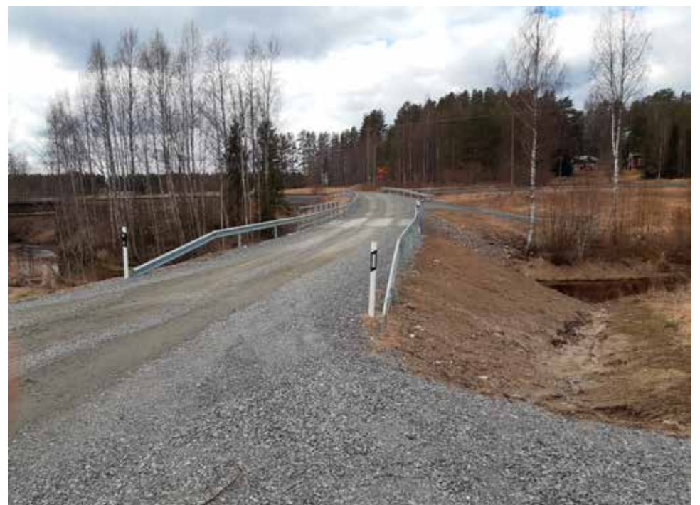
► Ruunun silta rakennettiin ELY:n avustuksella uusiksi.
