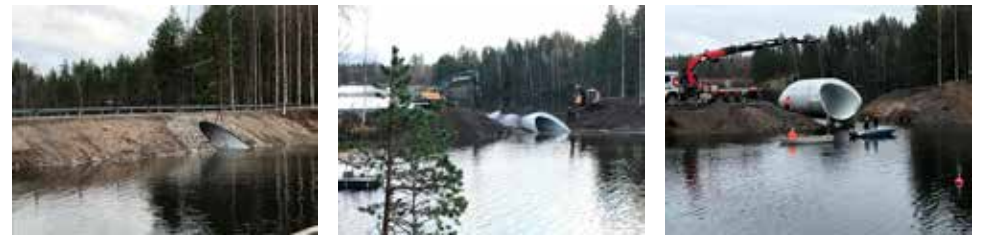
➤ Rumpu asennettiin tammikuussa 2020 Houtunsaaren ja Laamalan välisen Sorvasalmeen.
