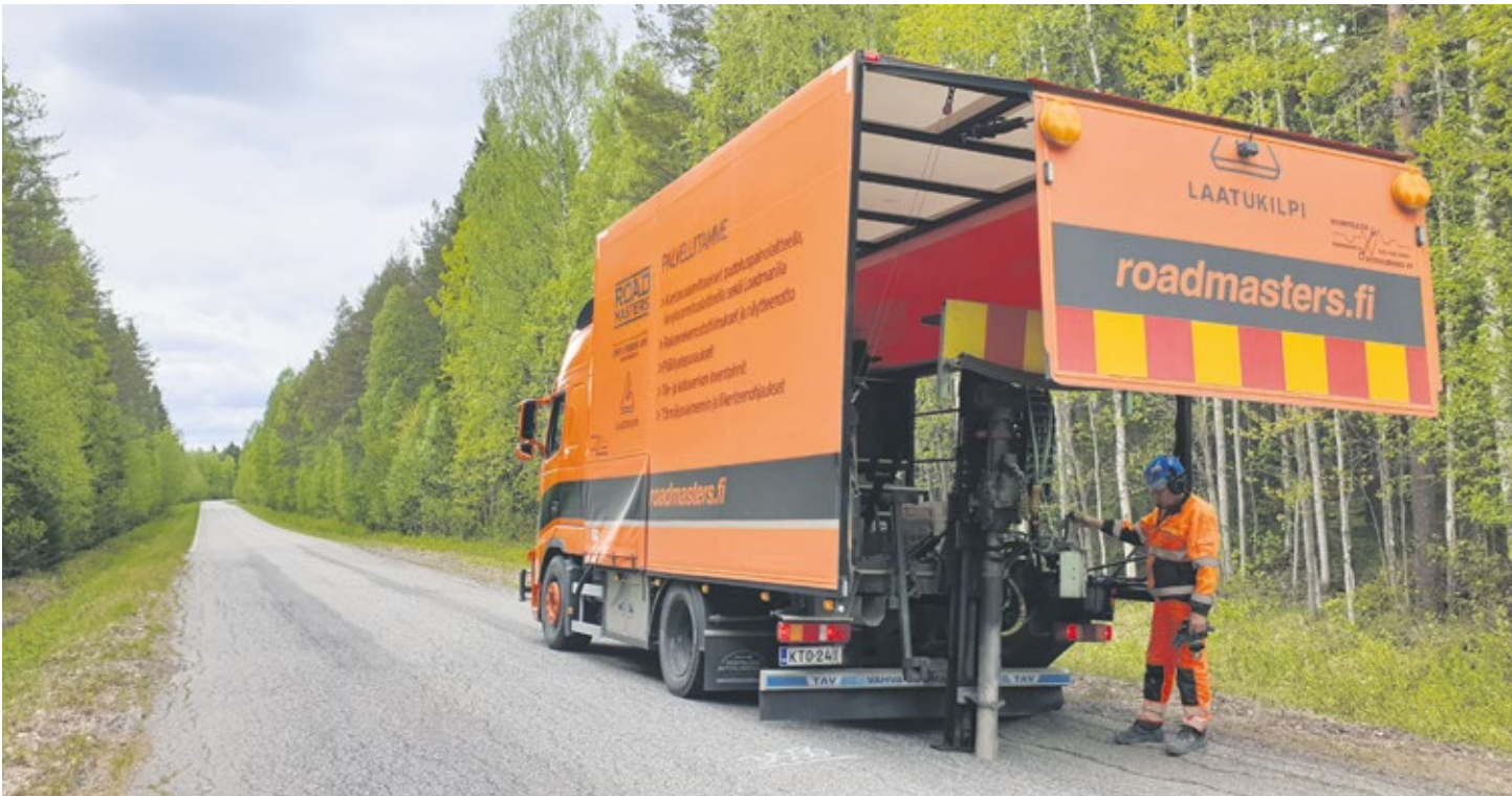
➤ Rakennekerroskairauksia ja näytteenottoa keväällä 2019 Sotkamossa.
