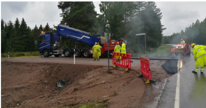
»Lopuksi liittymät saivat asfalttipäällysteen.
