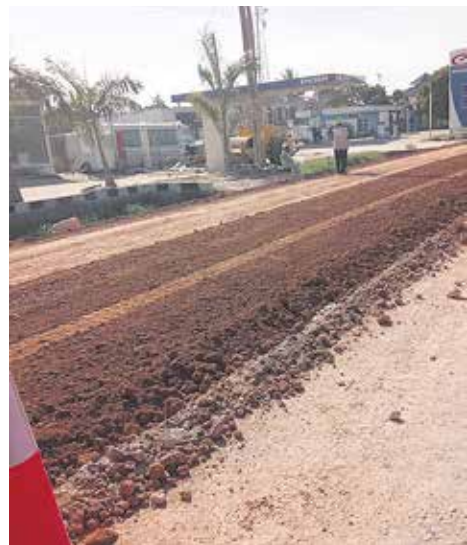
► Soratien kulutuskerroksen parantaminen meneillään.
