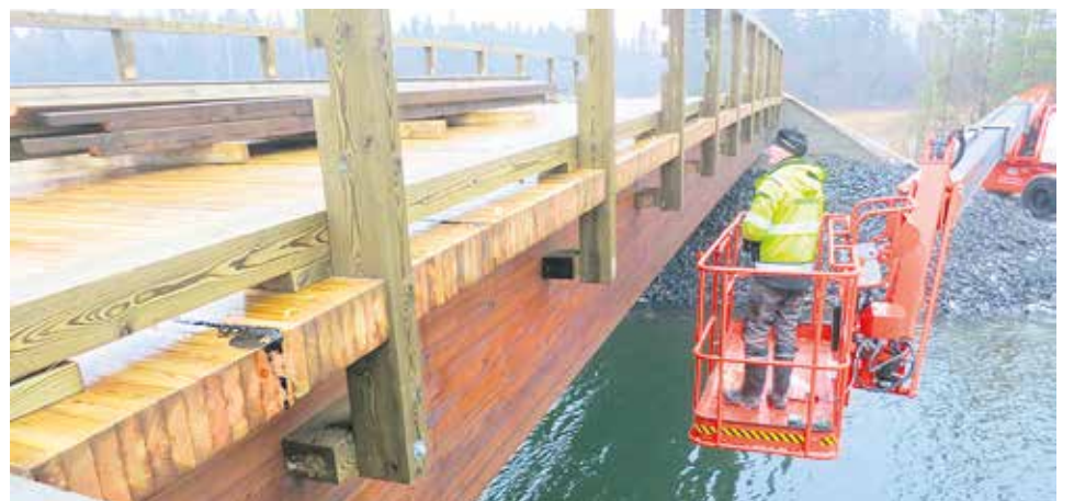
➤ Liimapuupalkit ovat kreosoottikyllästettyjä ja sillan kansi on koottu elementeistä.
