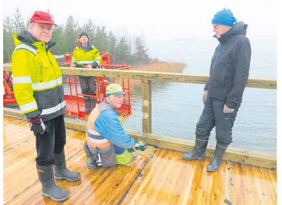
➤ Suunnittelu ja toteutus perustuvat senioriosaamiseen. Siltaurakan johtamisesta vastaa tieisäntä, rakennusmestari Pentti Raekallio (vas.).
