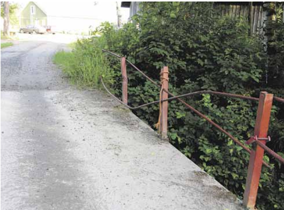
Tämä sillankaide ei taida enää paljoa pidätellä lapsia eikä autoja.
