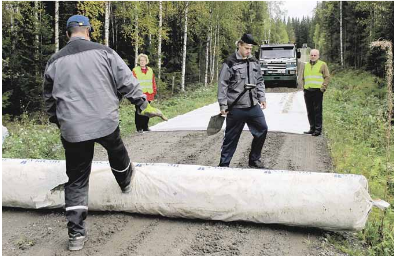
Suodantinkankaan asennus menossa Maansiirto Karvinen Oy:n toimesta.
