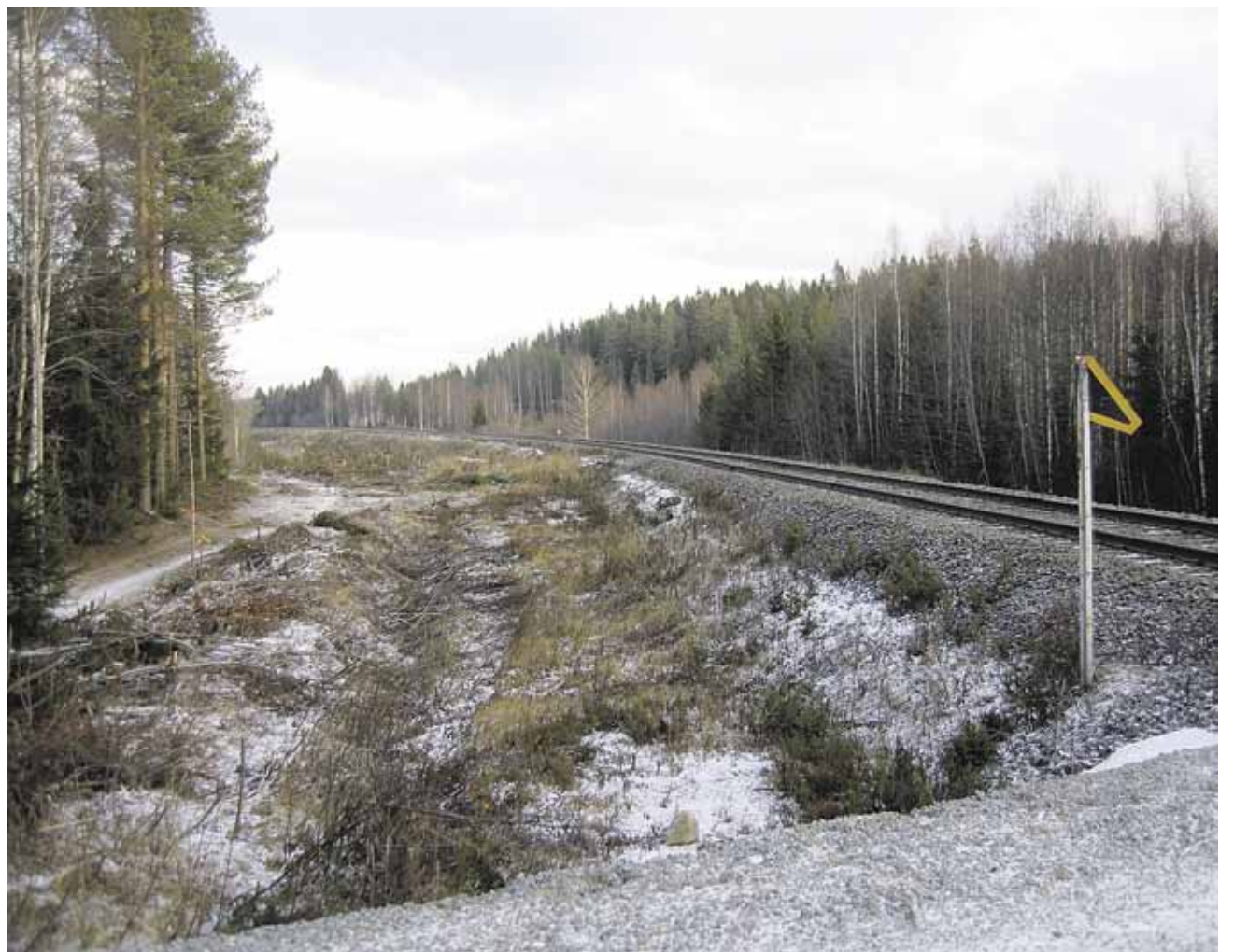
Tasoristeyks näkemäraivauksen jälkeen. Näkemäesteenä ollut puusto ulottui rautatiealueen ulkopuolellekin.
