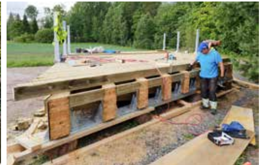
» Kantavan kansirakenteen kokoaminen tehtiin siltapaikan vieressä.
