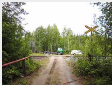
» Lähellä olevista tasoristeyksistä toisessa parannettiin tietä ja näkemiä. Toinen poistettiin ja sen liikenne ohjattiin kuvassa olevaan Ankeriasjärventien parannettuun tasoristeykseen.
