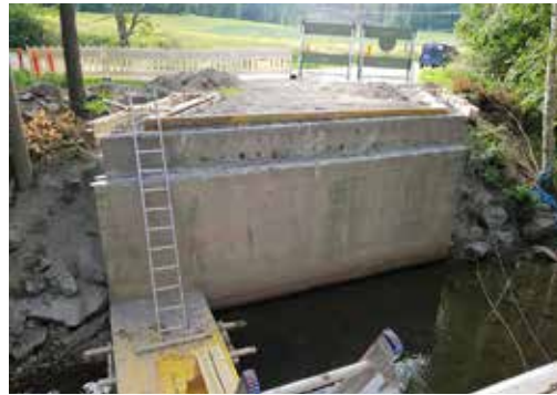
» Maatuille riitti korjaus ja vahvistus betonilla.
