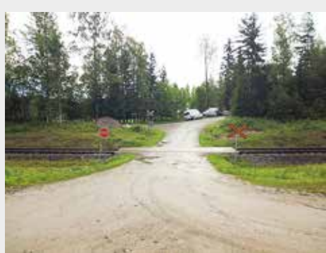
» Lemetilänmäentiellä parannettiin itse tietä ja sen näkemiä sekä rakennettiin puolipuumilaitos
