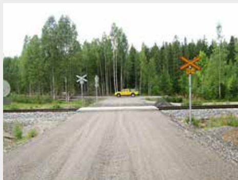
» Lähellä olevista tasoristeyksistä toisessa parannettiin tietä ja näkemiä. Toinen poistettiin ja sen liikenne ohjattiin kuvassa olevaan Ankeriasjärventien parannettuun tasoristeykseen.
