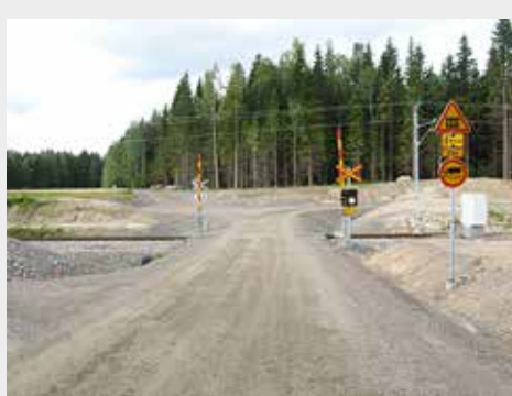
» Lemetilänmäentiellä parannettiin itse tietä ja sen näkemiä sekä rakennettiin puolipuumilaitos
