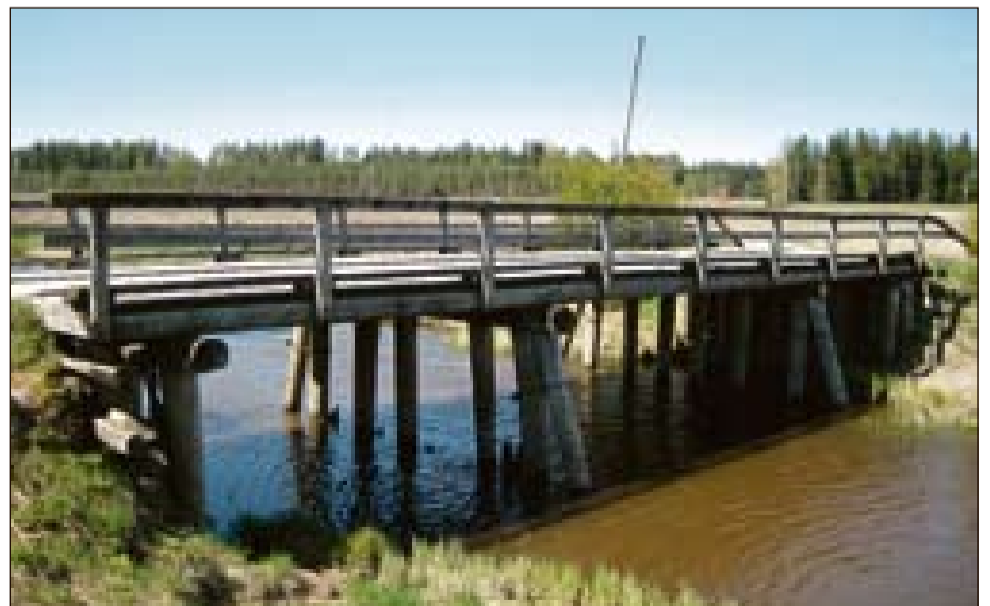
Vain jatkuvalla hoidolla ja kunnostuksella puusilta pysyy tarkoitustaan vastaavassa kunnossa.
