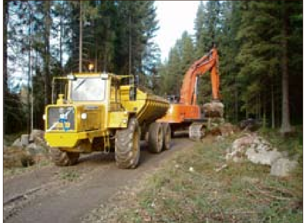
Kapea tie saatiin leveämmäksi poistamalla tien reuna-alueilta vanhat penkat ja kivet ojan kaivamisen yhteydessä.
