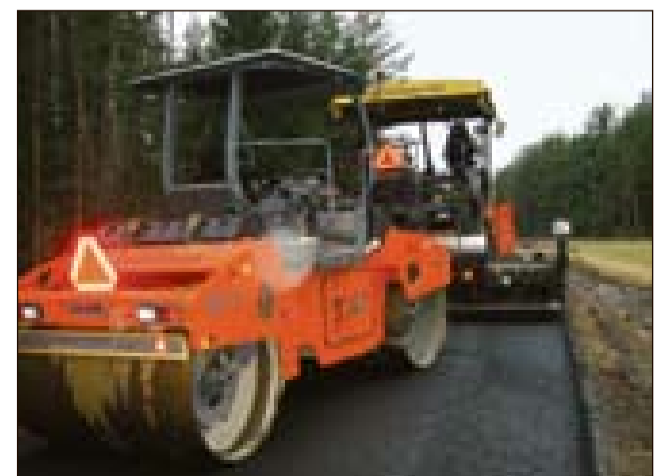
Vanhan öljysorapäällysteen sekoitusjyrsintä käynnissä.
