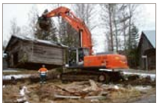
Rautaniementien liittymässä oleva lato oli aivan ajoradan reunassa ja se siirrettiin noin 20 m sivuun turvallisuuden parantamiseksi.
