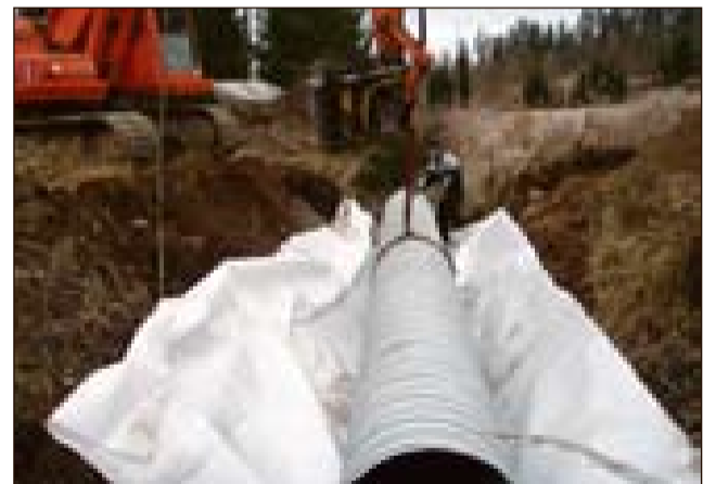
Teräsrummut suojattiin suodatinkankaalla ennen murskeiden asennusta ja tiivistämistä.
