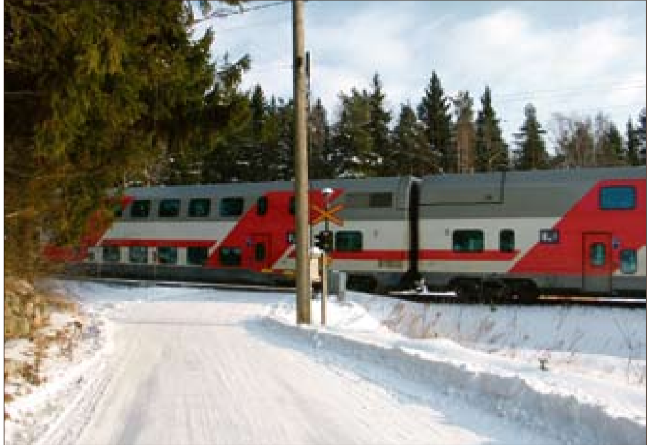
Hyvä lepotasanne ja näkemät kuuluvat nykyaikaiseen tasoristeykseen.
