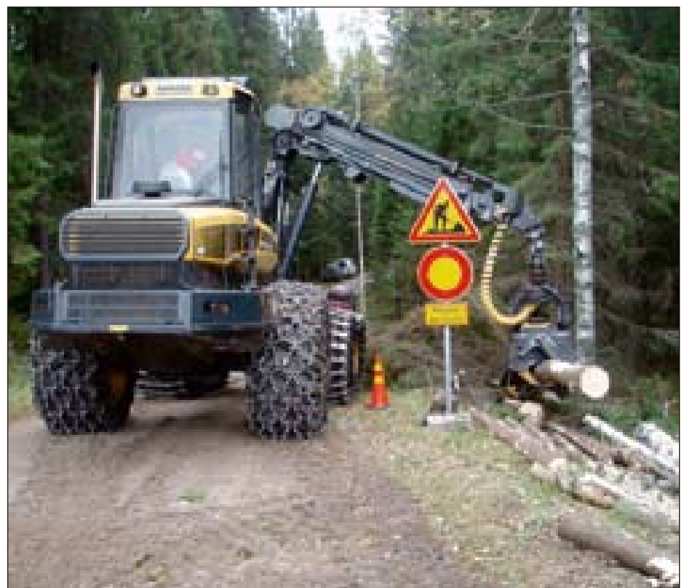
Tästä alkaa kapean tien leventtäminen Varessuontien parannushankkeella.
