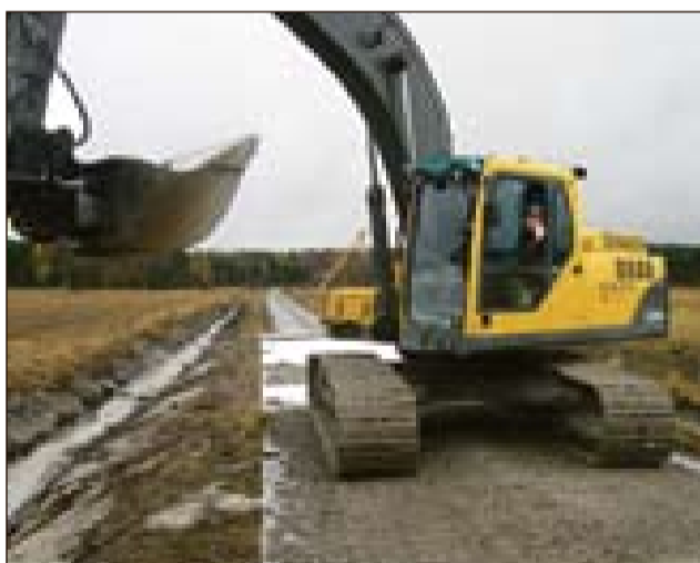
Yksityistien muotoilu ja vahvistaminen tapahtuu sidotulla kantavalla kerroksella (ABK).
