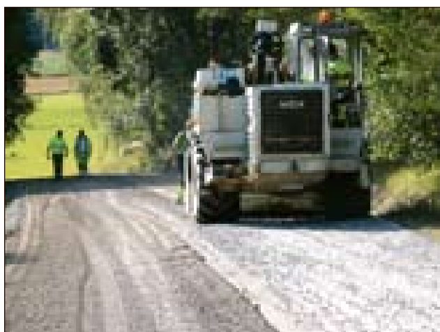
Kuvassa näkyvä tieosa ei ole kestänyt kunnolla puukujetuksia.
