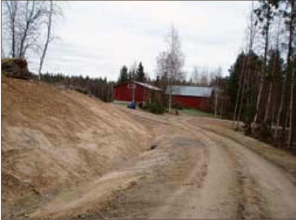
Peräläntien sivuhaaran risteyksessä Varessuontien kaarretta levennettiin, ja pengermät leikattiin ja luiskattiin siisteiksi.
