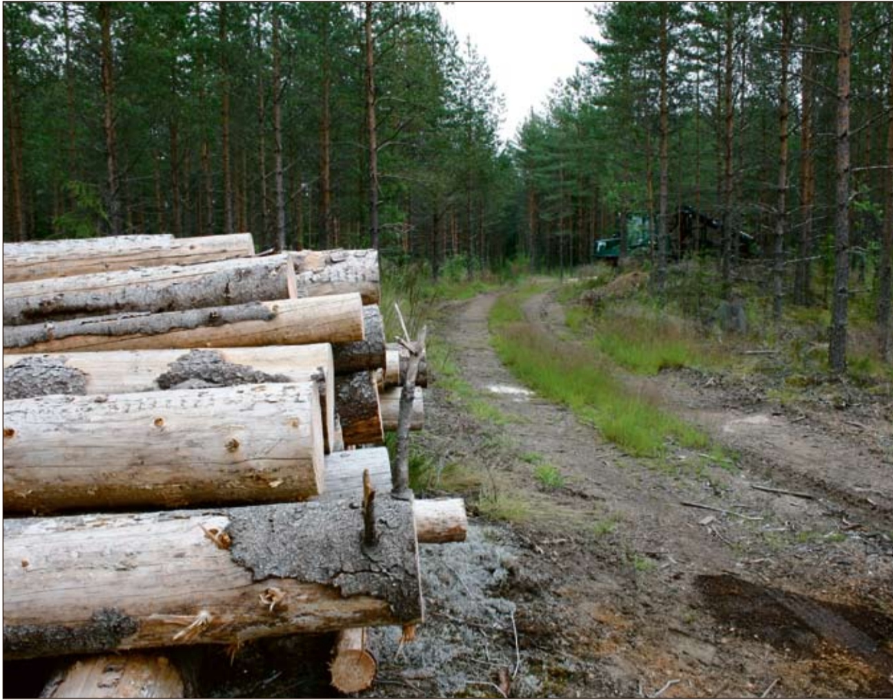
Valtaosa puusta lähtee yksityisteiden varresta. Tien riittämätön kantavuus on yksi puukuljetusten tyypillisimmistä pullonkauloista.
