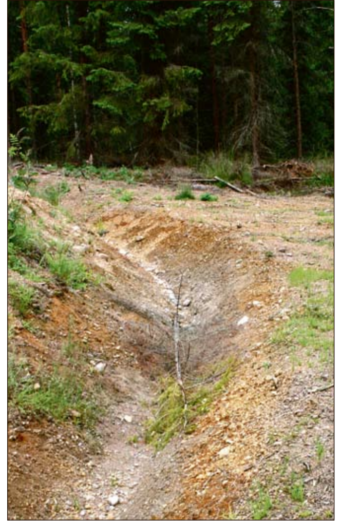
Tehtiinpä mitä muuta hyvänsä, on samalla huolehdittava tien kuivatuksesta. Ojat ja rummut kuntoon.
