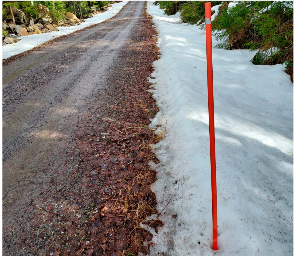
➤ Auraskeppi tulee asentaa sulaan maahan, jotta se pysyy paikoillaan koko talven. Kuva: Teuvo Taura, Suomen Tieyhdistys ry.
