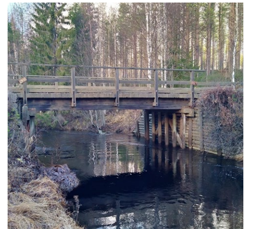
Liimapuinen palkkisilta (Pp) odottaa kaiteiden ja kansilankutuksen uusimista Hyrynsalmella.
