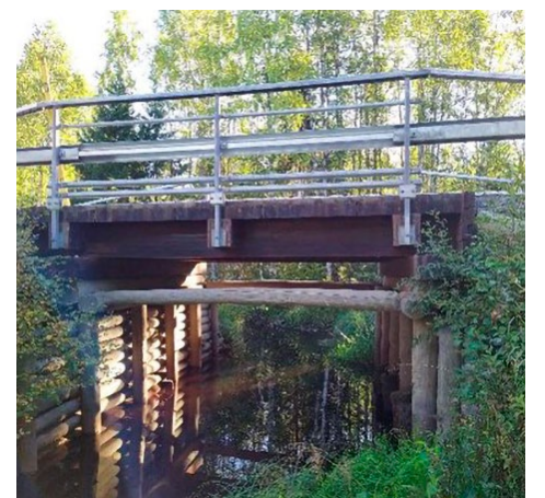
Siltaan on uusittu palkistot, kansi- ja kaiderakenteet vastaamaan nykyvaatimuksia.
