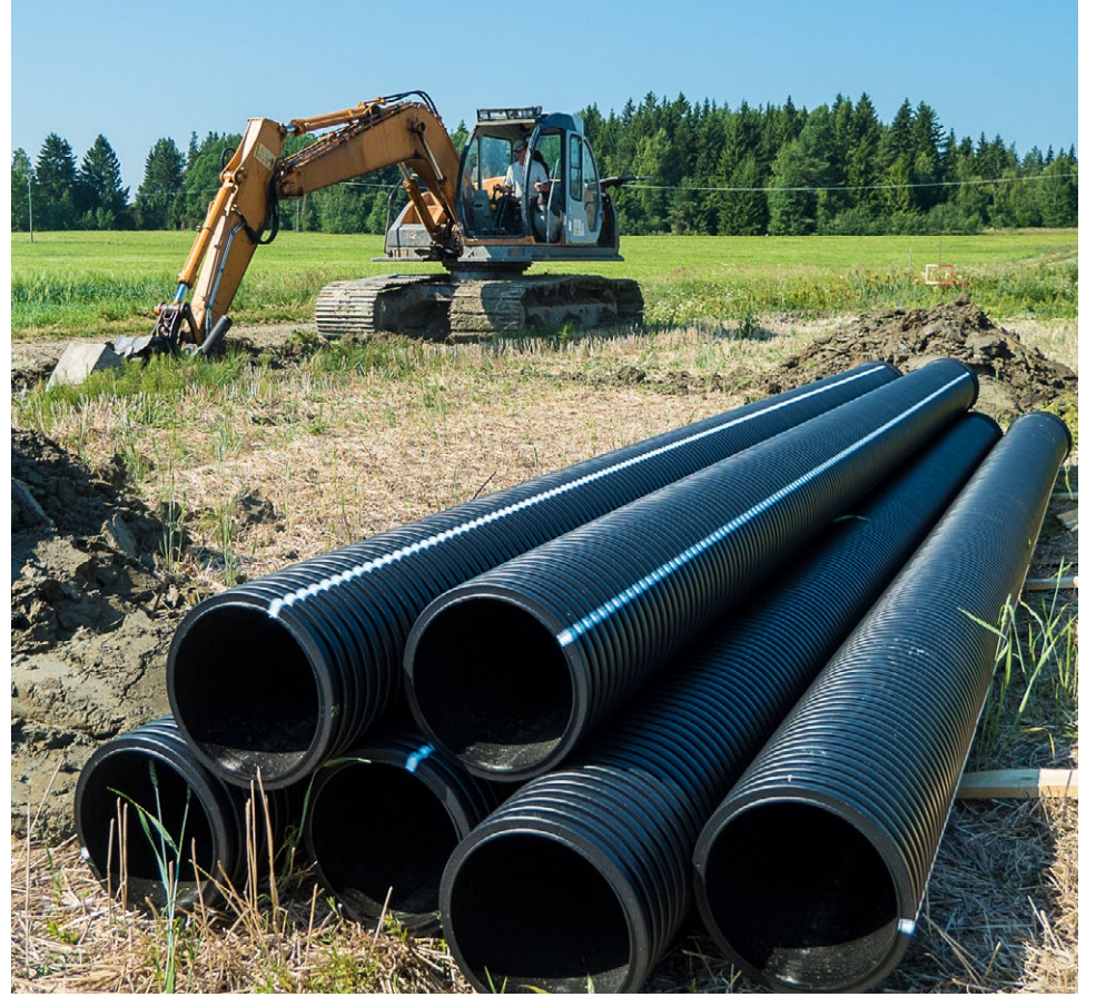
➤ Muoviputket on syytä säilyttää tasaisella paikalla asennukseen asti.
