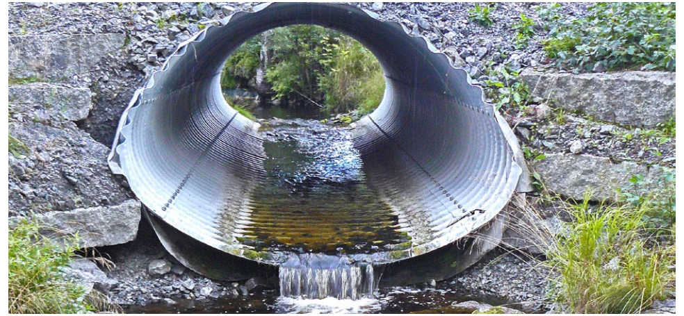
► Pisaranmalliset ovaalirummut eivät sovi pienille valuma-alueille, koska ne eivät supista virtaamia alivesi-kausina. Tämä rumpu on perustettu myös 40 cm liian ylös ja lohkokivet estävät eläinten vaelluksen alivesillä.
