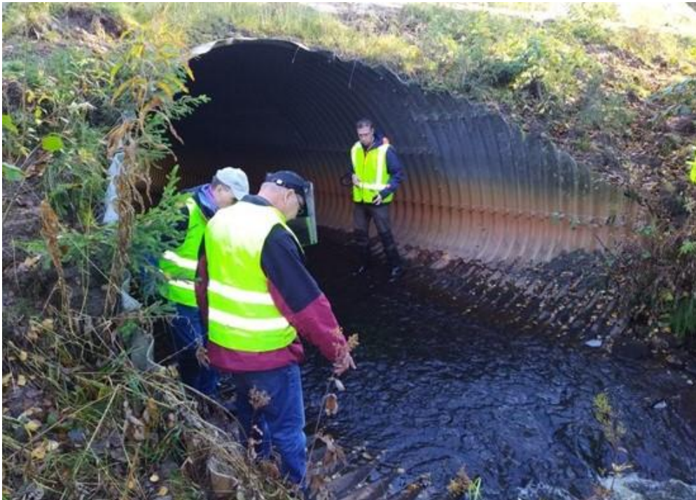
Kuva 17. Yksitystien sillan erikoistarkastus voi olla tarpeen, kun mietitään esimerkiksi sillan käyttökelpoisuutta. Kuva: Timo Pisto
