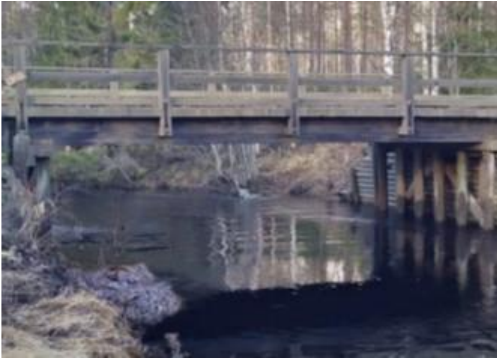
Kuva 3. Kuvassa oleva liimapuinen palkkisilta (Plp) on vielä ratkaisuna yleisesti käytössä ja sen perusparannustarve kannattaa selvittää vaihtoehtona kokonaan uuden sillan rakentamiselle. Kuva: Timo Pisto.
