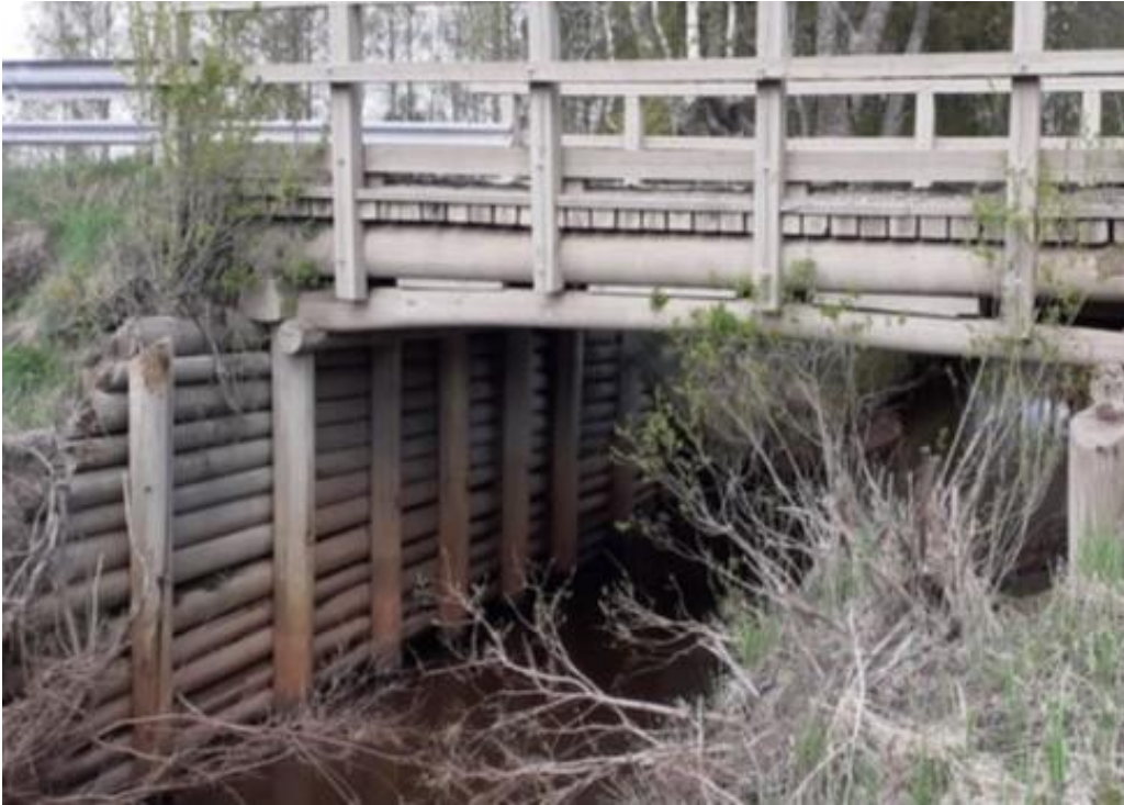
Kuva 1. Tukkisillat olivat yleisiä siltaratkaisuja vielä 1980-luvulla. Puuinfra-hankkeessa on tehty tukkisilloista mitoituslaskelmat nykyisten suunnitteluvaatimusten mukaisina. Kuva: Timo Pisto
