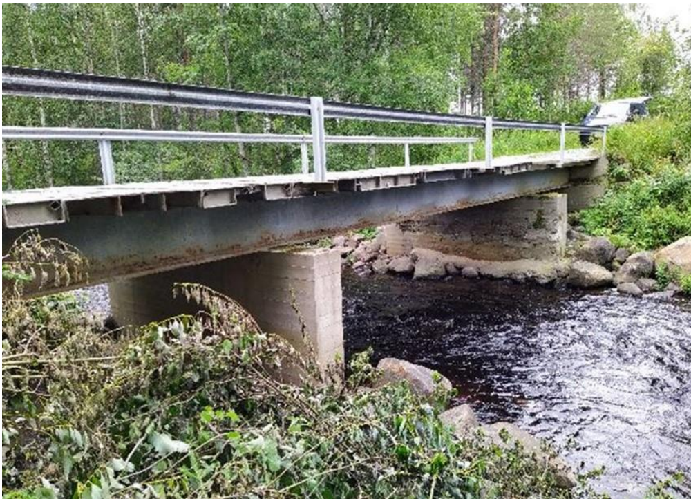
Kuva 18. Yksityisteiden siltoja on rakennettu monenlaisista tarpeista, tienpitäjien omien suunnitelmien ja ratkaisujen mukaisesti. Kuva: Timo Pisto
