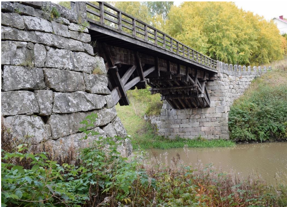
Kuva 8. Historiallisissa ansas-siltaratkaisuihin näkyy suomalainen siltasuunnittelu- ja rakentamisosaaminen sekä arkkitehtuuri.
