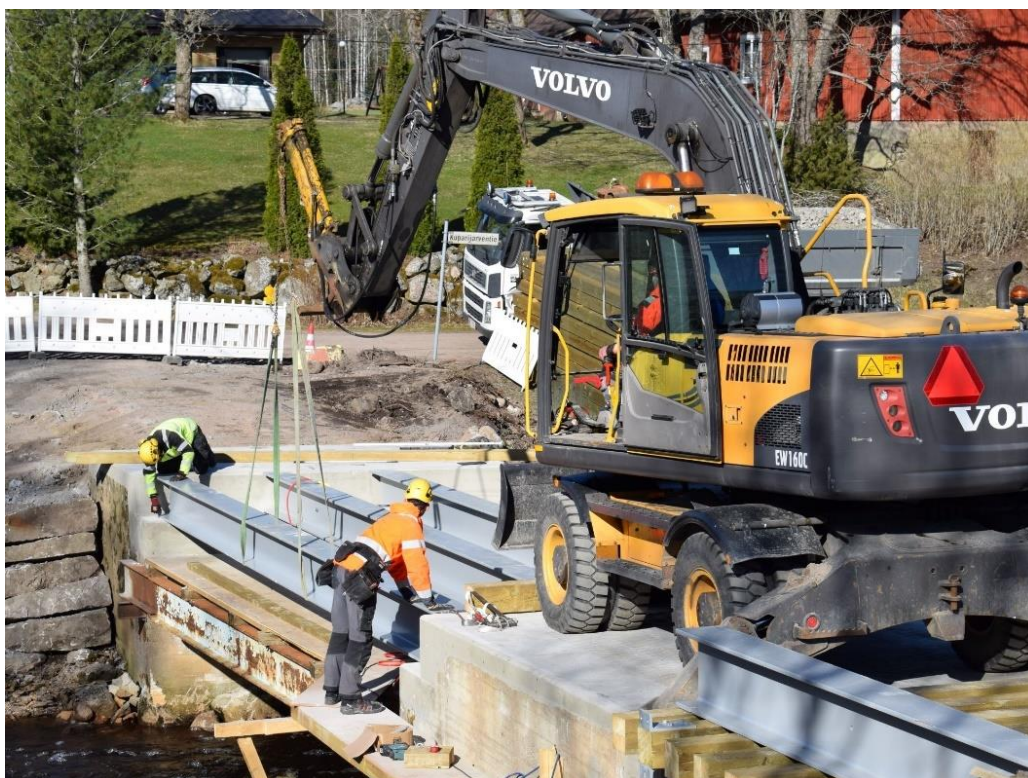
Kuva 26. Teräspalkkisiltaa asennetaan vanhoille maa- ja välituille. Kuva: Sakari Seppälä.
