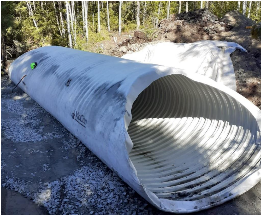
Kuva 33. Putkisilta on nostettu uomaan ja sen ympärillä on suodatinkangas suojaamassa sitä asennusvaiheen naarmuilta. Putken täyttövaihe voi alkaa , mikä tulee tehdä erityisen huolella sopivia kiviaineksia käyttäen. Kuva: Veikko Heikkinen.
