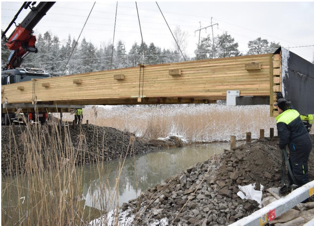
Kuva 22. Nykyiset tyyppihyväksytyt puusillat ovat teollisesti valmistettuja ja ne voidaan kuljettaa siltakohteelle kokonaisina. Sillan liimapalkkirakenne voidaan koota hallissa ja kuljettaa siltakohteelle. Kuva: Sakari Seppälä
