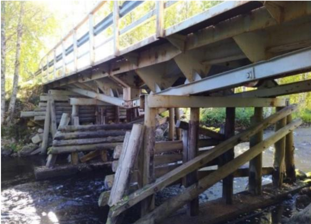
Kuva 9. Yksityisteiltä löytyy lukusia omia ratkaisuja, joille ei pysty määrittelemään kantavuuksia. Ne ovat tiekuntien vastuiden näkökulmasta suuri riski. Kuva: Timo Pisto.
