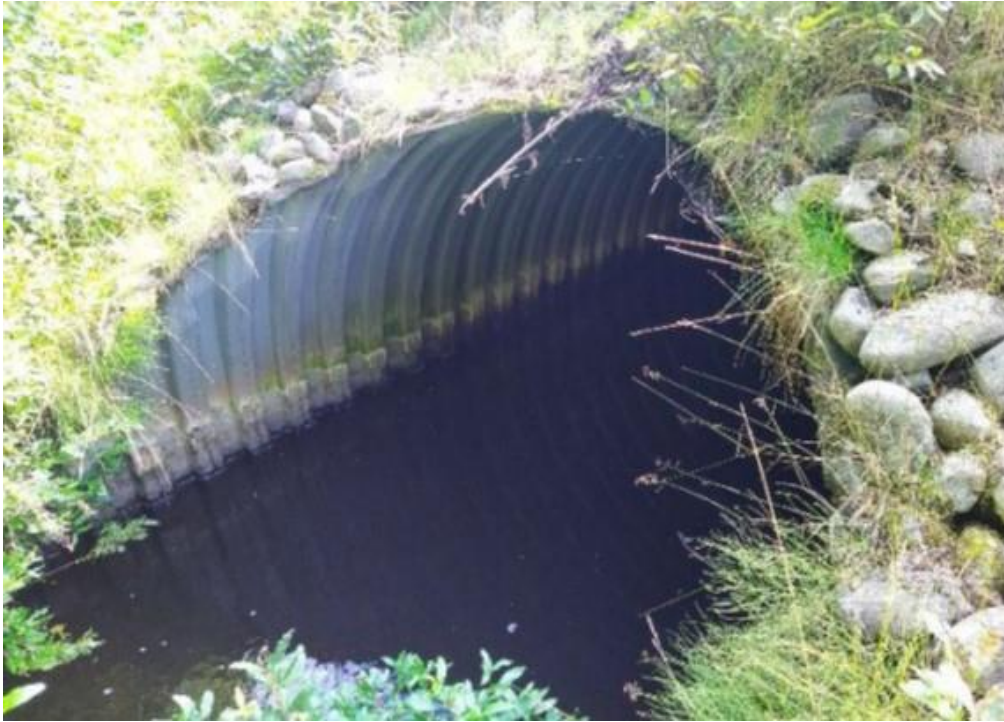
Kuva 5. Teräsputkien suosio rumpuna ja putkisiltana on kasvanut 1980-luvulta lähtien. Kuva: Sakari Seppälä.
