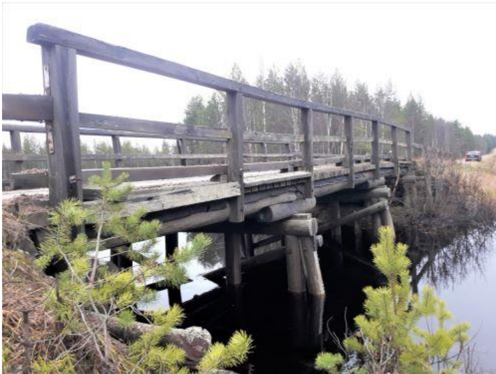
Kuva 2. Jatkuvia puupalkkisilloja (Pjp) rakennettiin ennen leveämpien jokien ylityksiin. Kuva: Petri Repola
