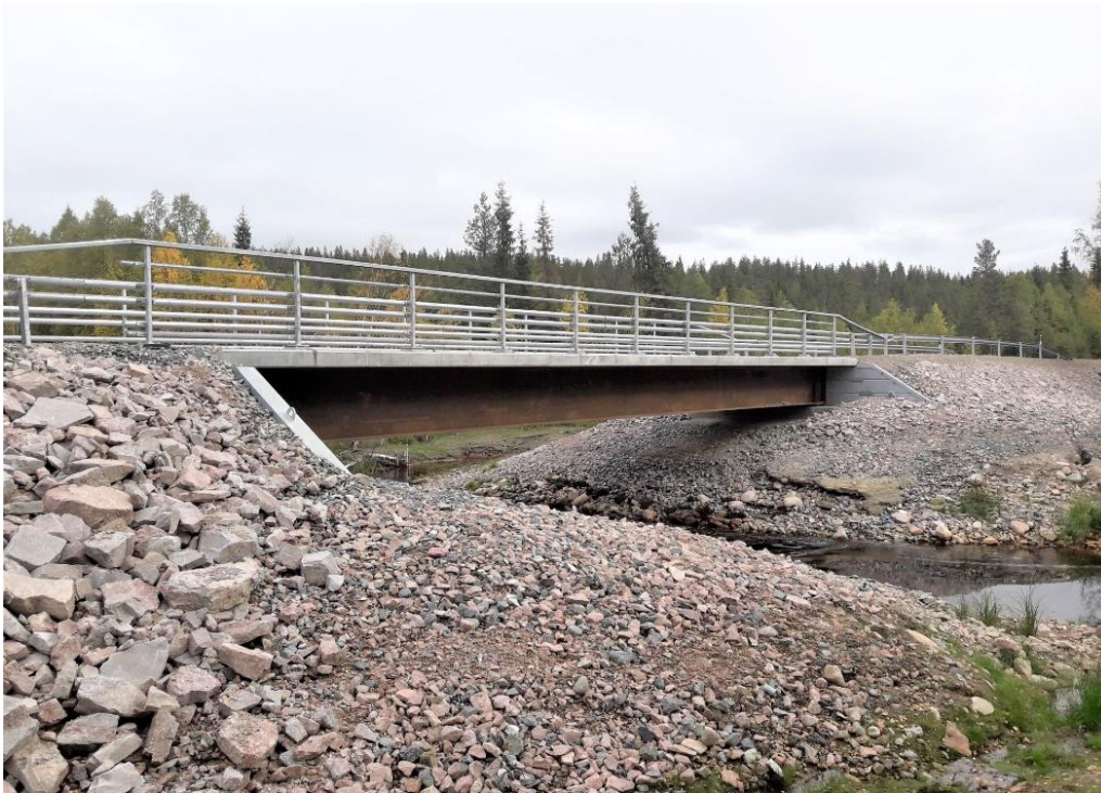
Kuva 24. Nordec Easy Bridge -ratkaisu soveltuu uusiin ja olemassa oleviin siltakohteisiin 11–35 metrin jännevälille. Kuva: Veikko Heikkinen.
