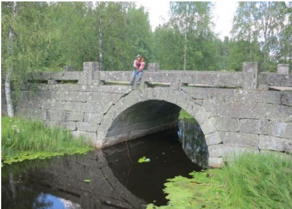
Kuva 6. Suomesta löytyy myös vanhoja kiviholvisilloja, joista useimmat ovat toimineet aikanaan yleisen tien siltana. Nämä sillat ovat usein myös suojeltuja museosilloja, mikä on huomioitava niiden korjauksissa. Kuva: Sakari Seppälä.
