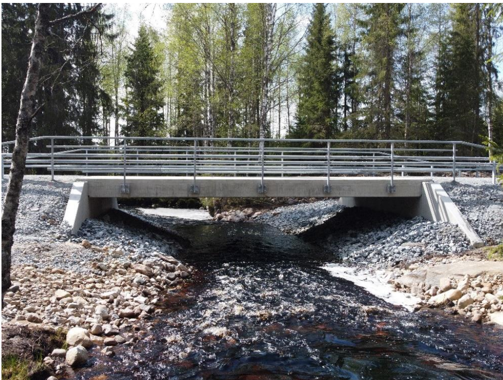
Kuva 23. Elementtilaattasilan kantava kansirakenne muodostuu kolmesta tai neljästä kansilaatasta, jotka ovat teräsbetonia. Laatta kannatetaan päistään päätymuureilla. Kuva: Veikko Heikkinen.
