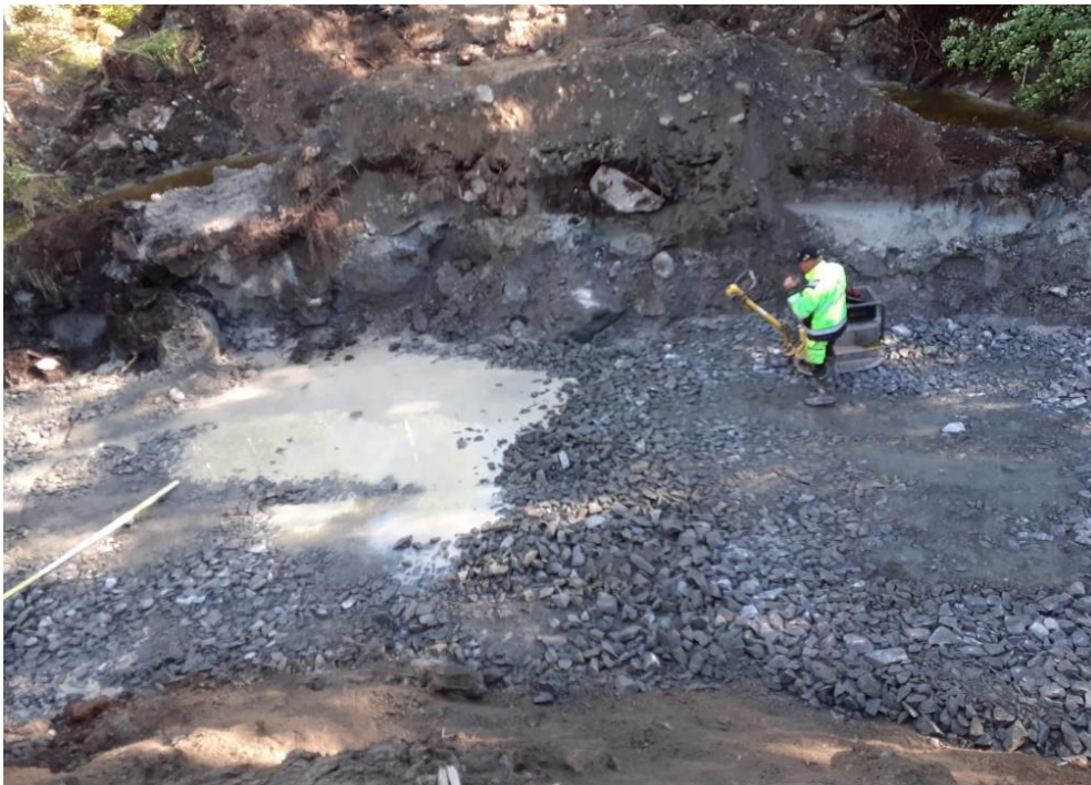
Kuva 32. Jo alkuvaiheen suunnittelussa silta päätettiin korvata putkisillalla. Pohjanvahvistus tehtiin kerroksittain hyvin tiivistäen. Kuva: Veikko Heikkinen.
