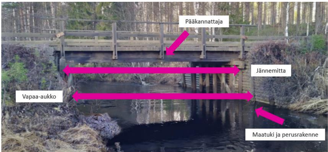
Kuva 10. Sillan rakenneosia ja mittoja. Kuva: Timo Pisto
