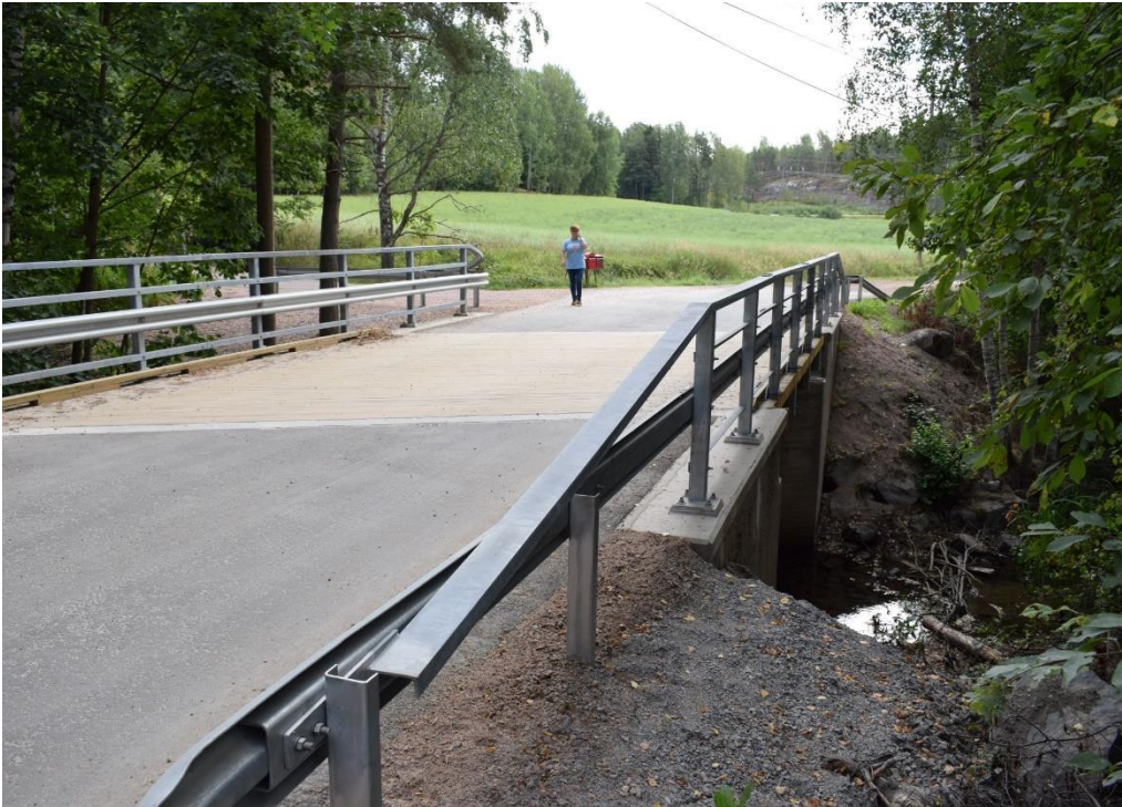
Kuva 27. Siltaurakan vastaanottotarkastus voidaan aloittaa. Kuva: Sakari Seppälä.
