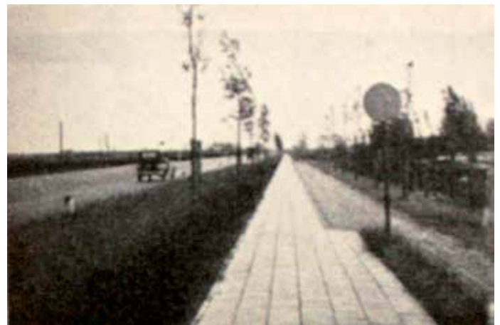
Betonilaatoista tehty pyörätie Rotterdamin-Haagin valtatie varrella.
