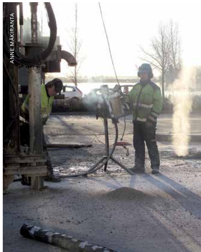
Asfalttikaivojen poraus käynnissä. Höyrypatsas kertoo asfaltin alta nousevasta lämmöstä.
