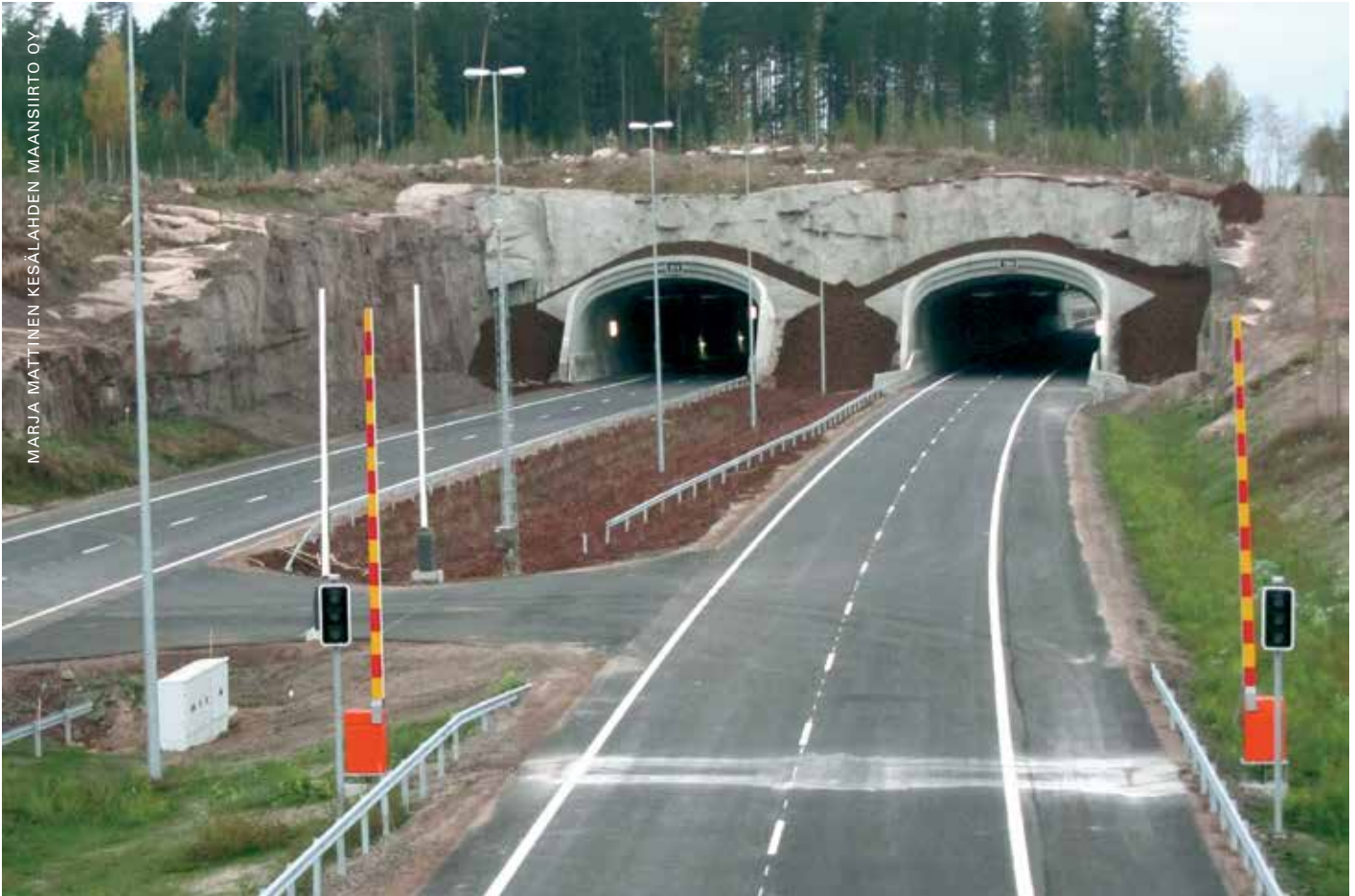
Kolsilan tunnelin päällä kasvava metsä tummentaa lähestymisaluetta ja pienentää tunnelivalaistuksen tehontarvetta. Kuvassa tunnelia ei ole vielä avattu liikenteelle eikä tunnelivalaistus ole toiminnassa.
