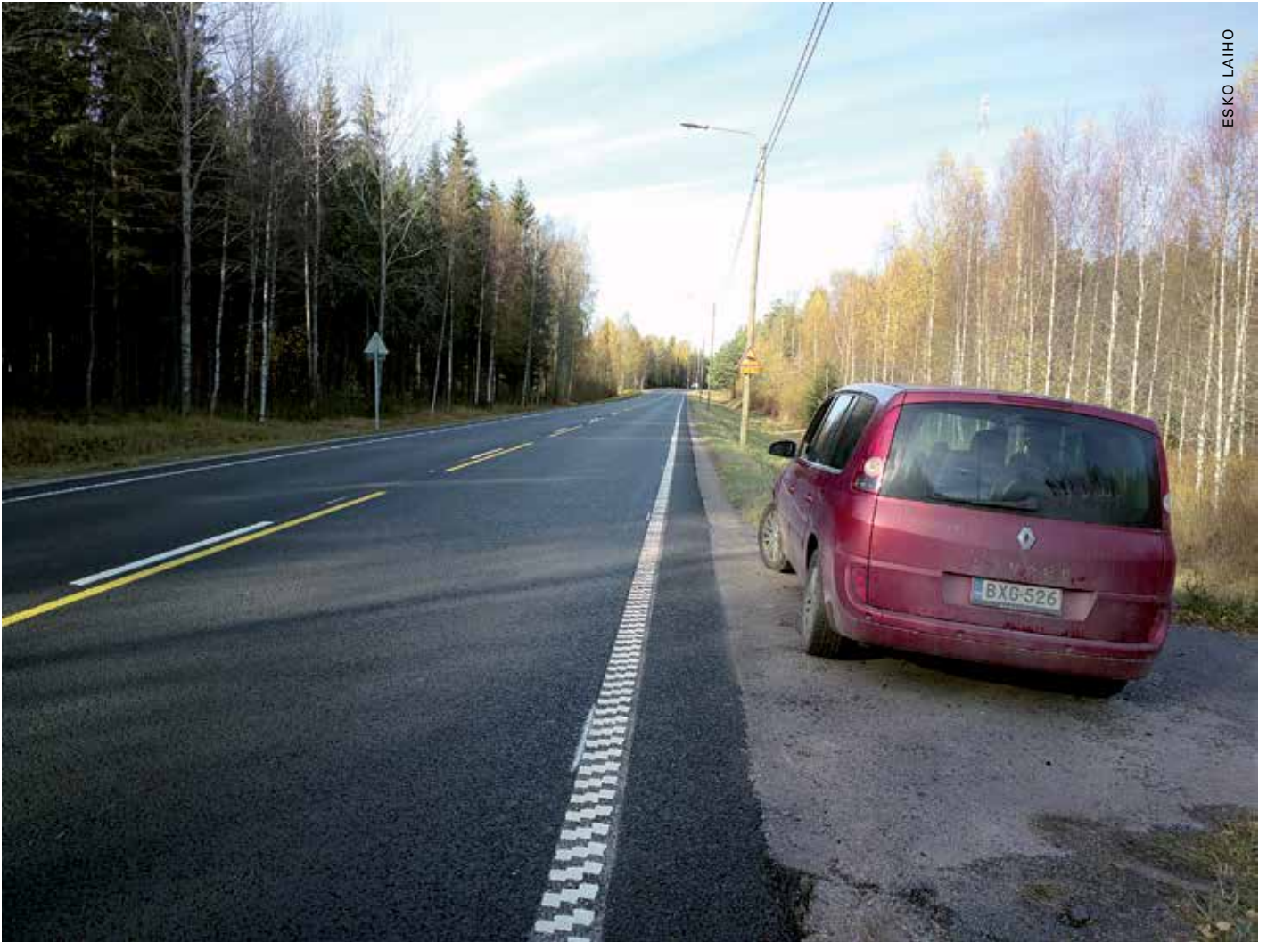
Siniaallon muotoiseen jyrshintään tehtyä porrasmerkintää valtatiellä 8 syyskuussa 2013.
