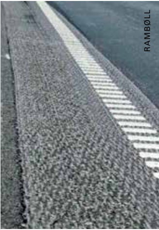
Tasaiseen jyrintään vuosina 2001–2002 upotettua raitamerkintää Norjassa.
