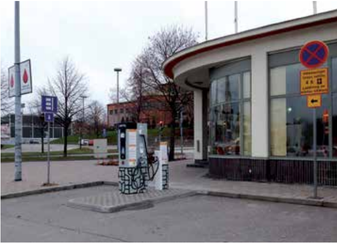
Käyttäjystävällinen latauspiste pika- ja peruslatauksella Turun linja-autoasemalla, jossa yksi parkkiruutu on otettu latauslaitteiston käyttöön.
