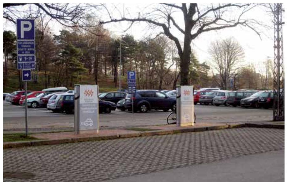
Peruslatauspisteet neljälle autolle Helsingissä Töölön kisahallin edustalla. Latauslaite on sijoitettu korotetulle alueelle siten, että vierekkäisten autojen on tarkoitettu käyttävän samaa laitetta.
