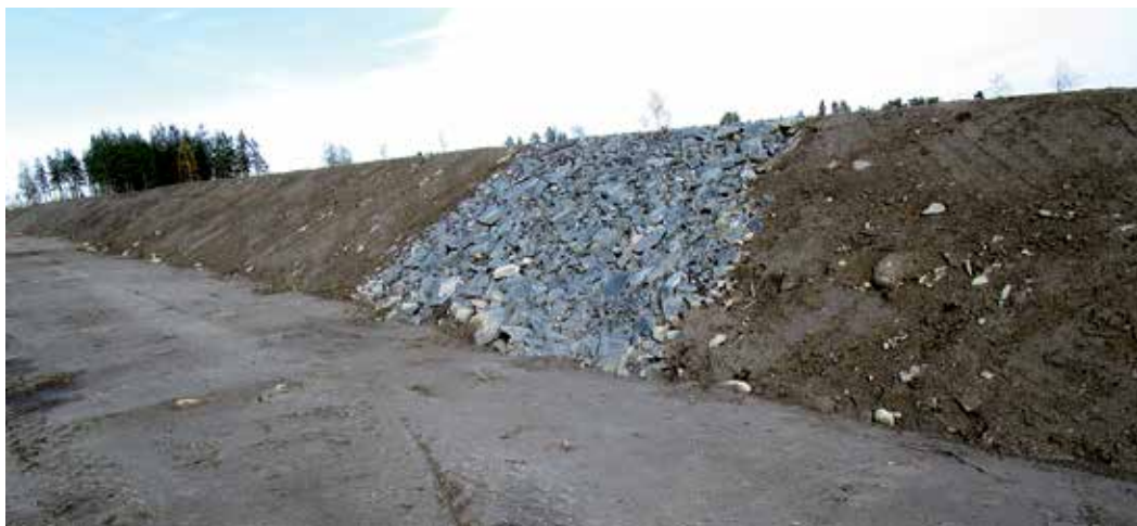
Matalamäen eteläpuolisen vastaanottoalueen vastapenger.
