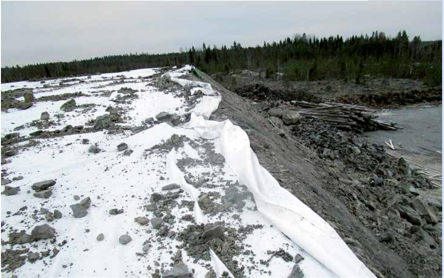
Suodatinkankaalla peitetty turvetuhkapenger, Matalamäki pohjoinen.
