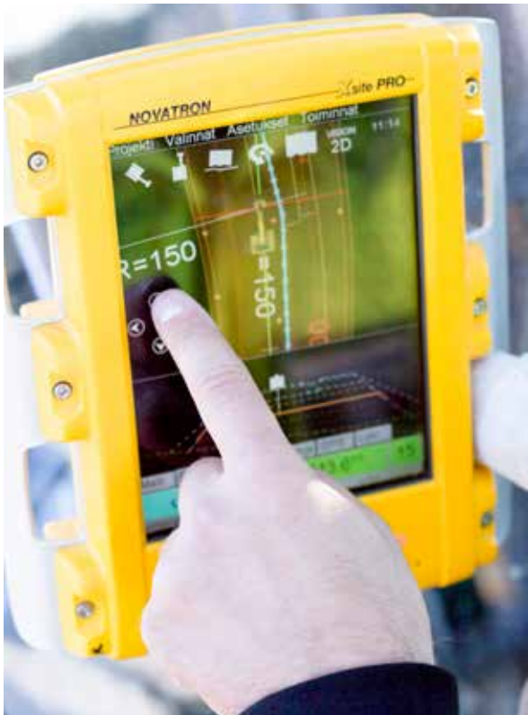
Luostarinväen eritasoliittymähankkeessa kaivinkonetta käytettiin tietomallipohjaisesti.
