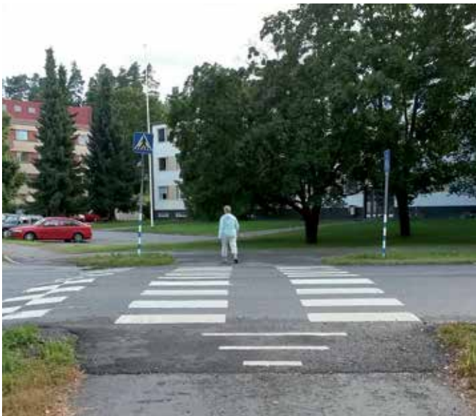
Turengissa suojatietä korostettiin lisäämällä jalankulku- ja pyörätielle heräteviivat.
