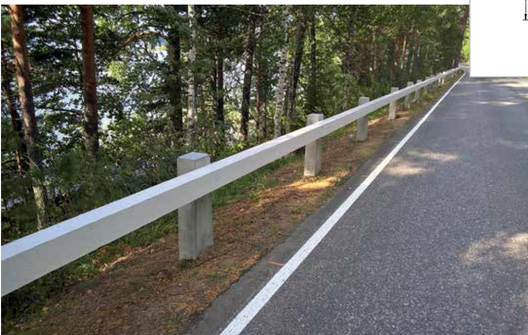
Vanhaa yksijohteista puukaidetta kunnostettiin 30-luvun malliin noin 0,5 km. Valkoinen väri on alun perin tarkoitettu huomiöväriksi.
