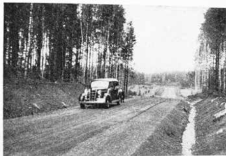
Kuva 4. Meikäläinen 6 metrin tie, jonka hyödyllinen leveys on vain 4,5–5,0 metriä.*)
