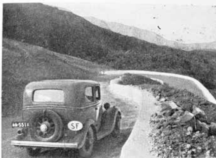
Kuva 58. Vesuviuksen huipulle johtavan tien betonikaide.
