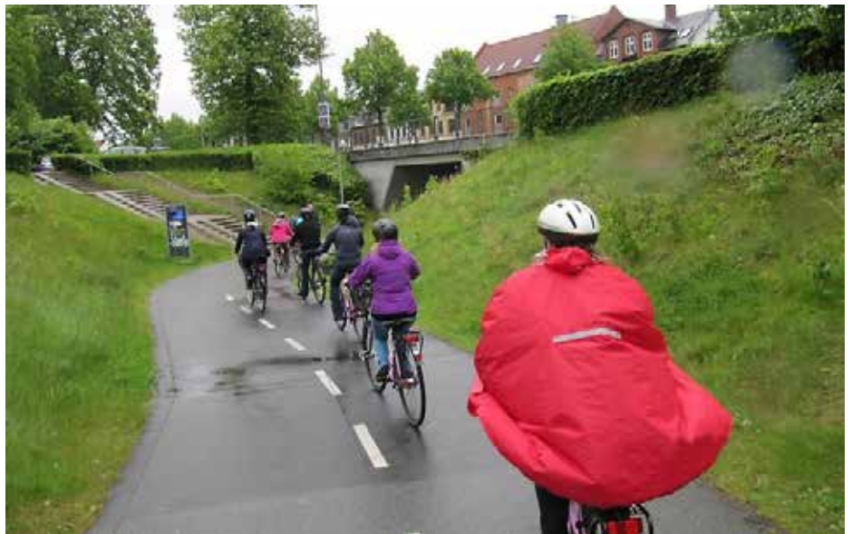
Tavallisesti erottelu tapahtuu siten, että rakennetaan erillisiä jalankulku- ja pyöräilyväyliä sekä eritasoristeyksiä kohtiin, joissa autoliikennevirta on tiheä ja/tai autojen ajonopeudet korkeita. Kuva Eija Yli-Halkola / Destia Oy
