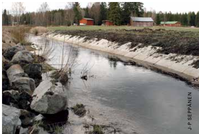
Jokipenkkojen päällystäminen niksibetonilla estää eroosiota.
