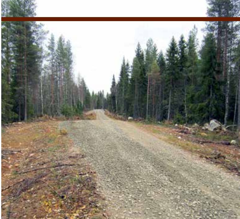
Metsäautotien liittymässä, jossa se liittyy tiehen kaareutuen ja eri tasolta, saa täyteen kuormatun puunkuljetusauton kuljettaja olla tarkkana hyvälläkin kelillä.
