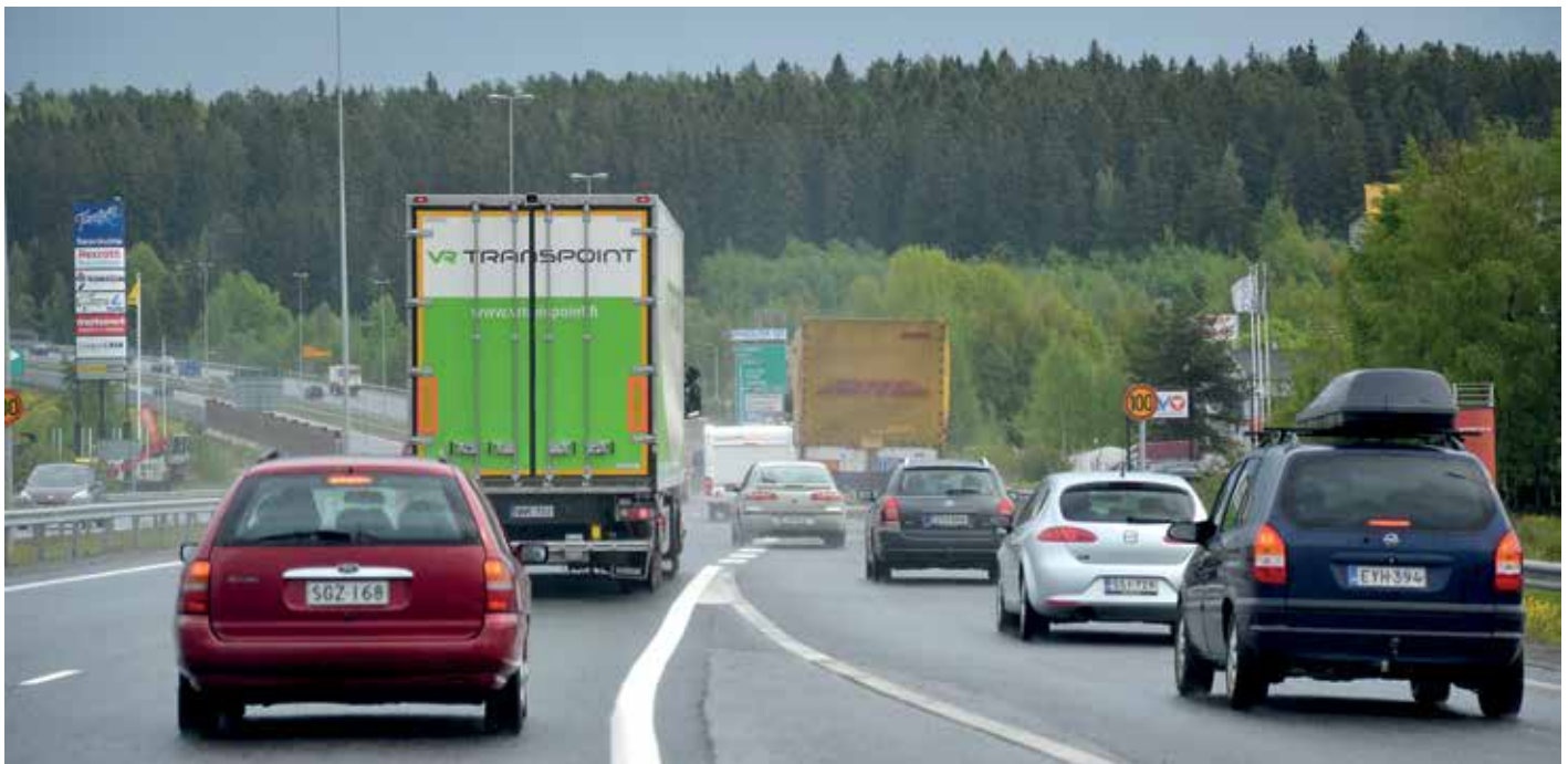
Valtatien 3 Läntisen kehätien liikennemäärät ovat kasvaneet yli ennusteiden. Muuttuvilla nopeusrajoituksilla (toteutus vuoden 2014 aikana) parannetaan liikenteen toimivuutta ja liikenneturvallisuutta.
