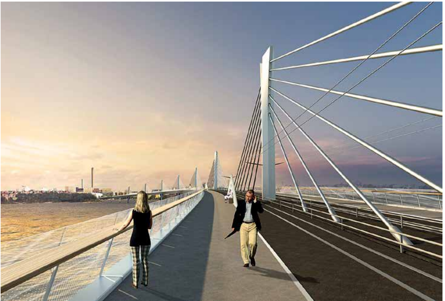
Kruunusillat-siltakilpailun extradosed-silta vaihtoehto. WSP Finland Oy 2013
