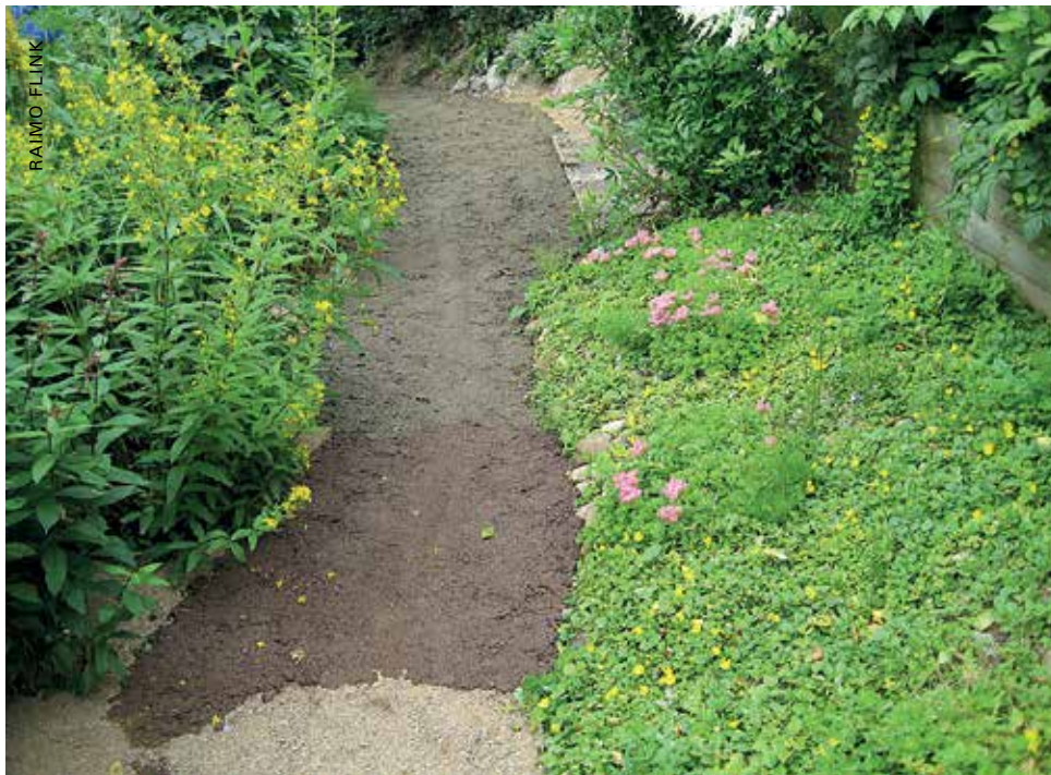
Vuosikausien kestäneissä kokeissa olen todennut, että sitkeä niksibetoni kestää rouhimista murtumatta. Polku on reunoilta 5 cm ja keskeltä 2 cm paksu.
