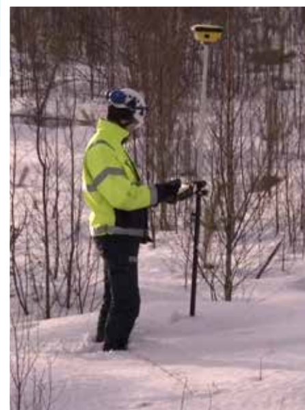
Työn suunnittelua maastossa käyttäen apuna RTK-GNSS-mittalaitetta - Vt19 Seinäjoen itäinen ohikulkutie.
