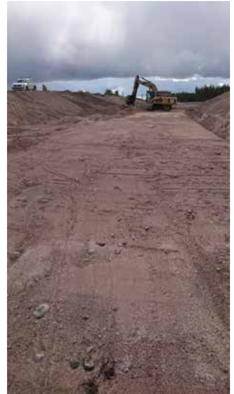
Väylärakenteen alapinnan leikkausta koneohjatulla kaivukoneella - Vt6 Taavetti-Lappeenranta.
