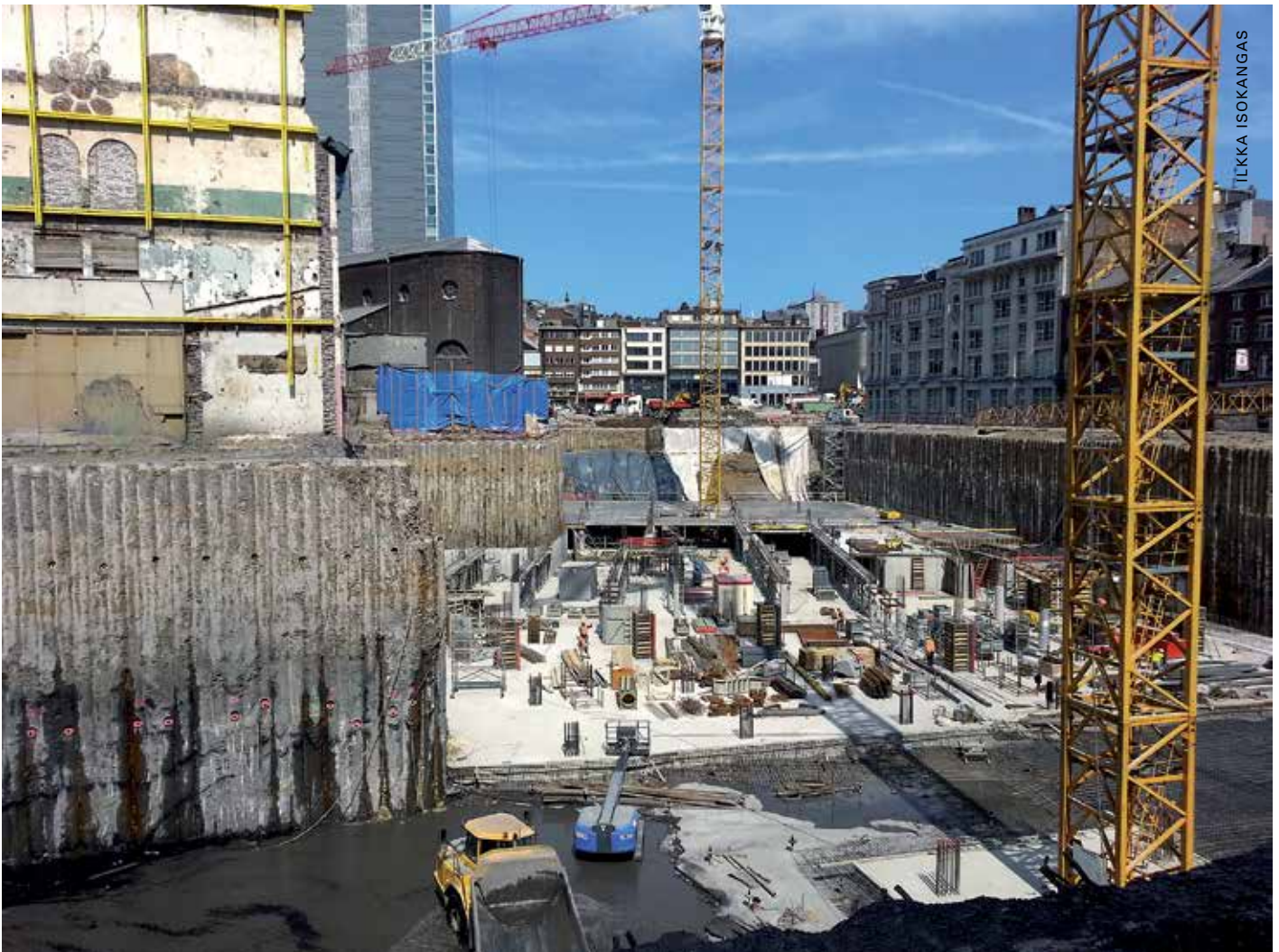
Rive Gauchen työmaa kaivinpaaluseinineen.
