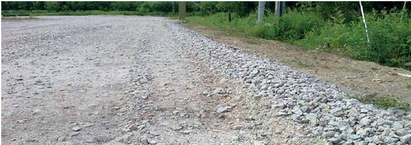
Kantava kerros tiehöylällä levitettyinä.
