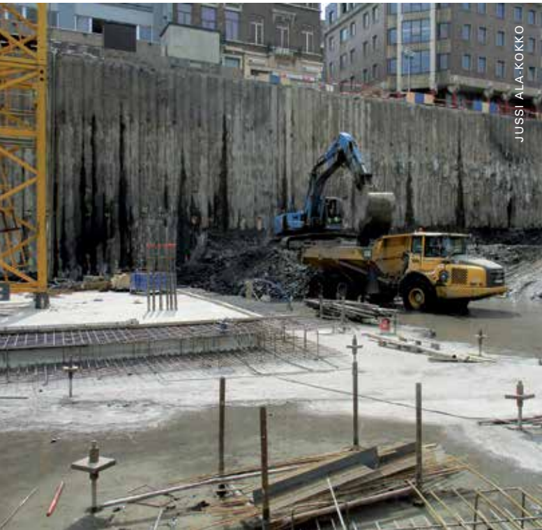
Rive Gauchen työmaalla kallion irrotusta kaivinkoneella.
