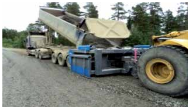
Kantavan kerroksen levittäminen murskelevittimellä.
