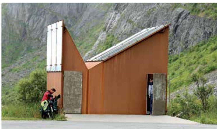
Akkarvikoddenin toilettirakennus, jonka muodot linjaavat ympäröiviä tunturirinteitä. Lasikatot tuovat sisätiloihin valoa.
