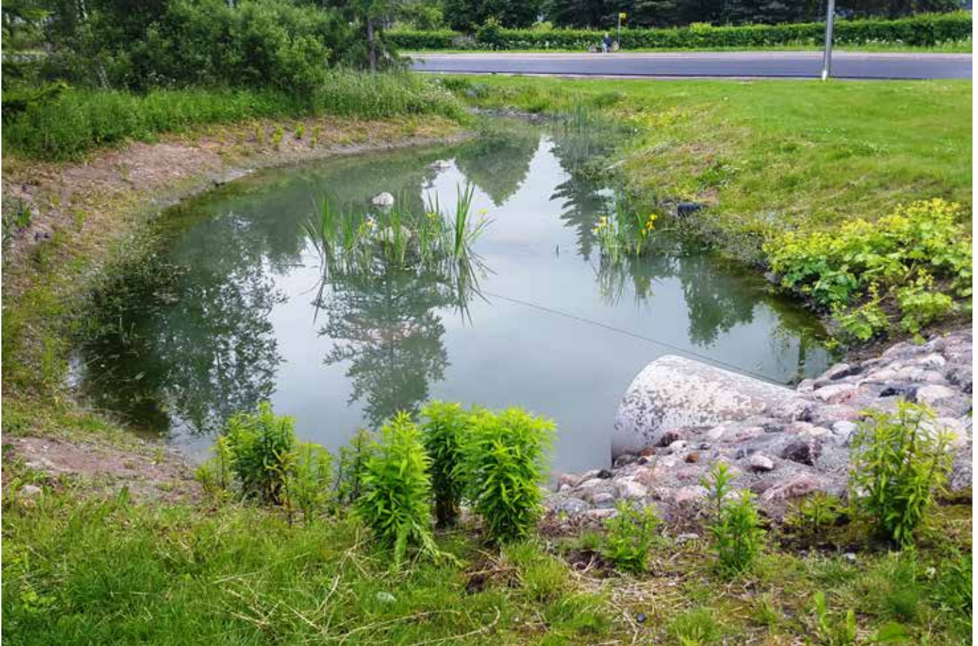
Lahdessa sijaitseva tiealueen hulevesien laskeutusallas kesällä 2017 vuoden kuluttua rakentamisestaan.
