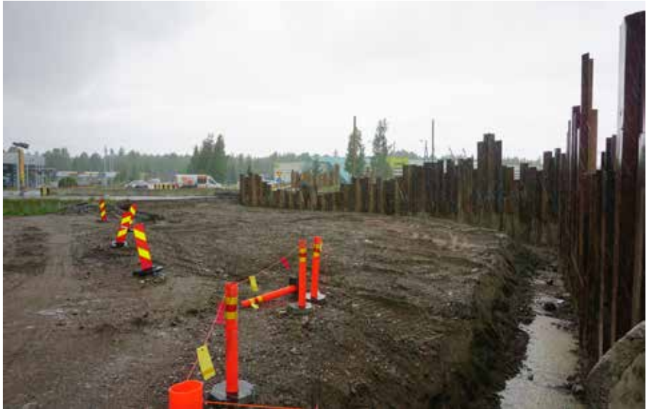
Uudenmaankatu levennetään nelikaistaiseksi moottori- ja kehätien välillä. Samalla parannetaan kevyen liikenteen yhteyksiä, kuvassa kadun suuntaisen kevyen liikenteen sillan työmaan ponttiseinä.
