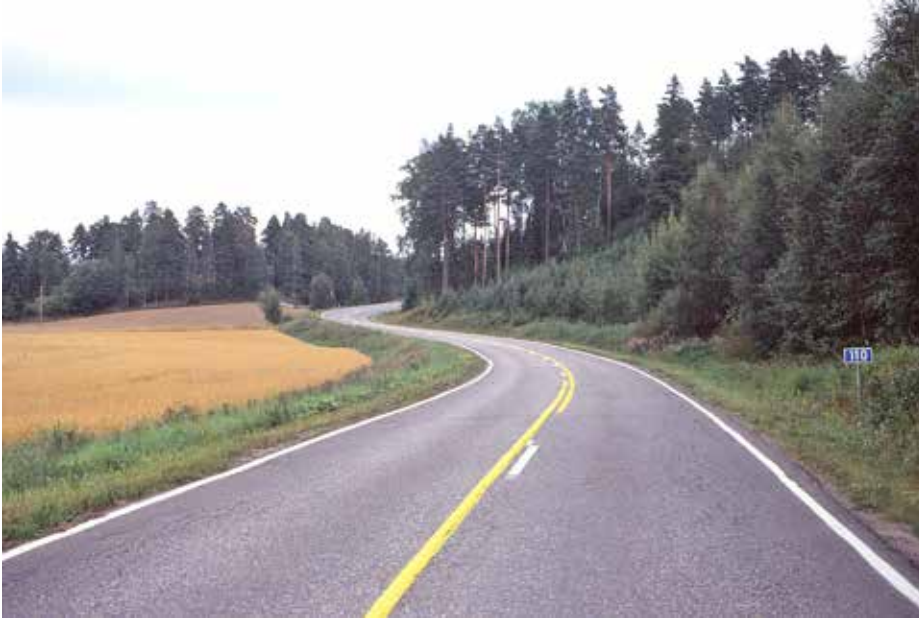
Vanha seututie (Raasepori) on parannettu ilman tuntuva nostoa. Tulos ilahduttaa autoilijoita ja on tekijöilleen kunniaksi.
