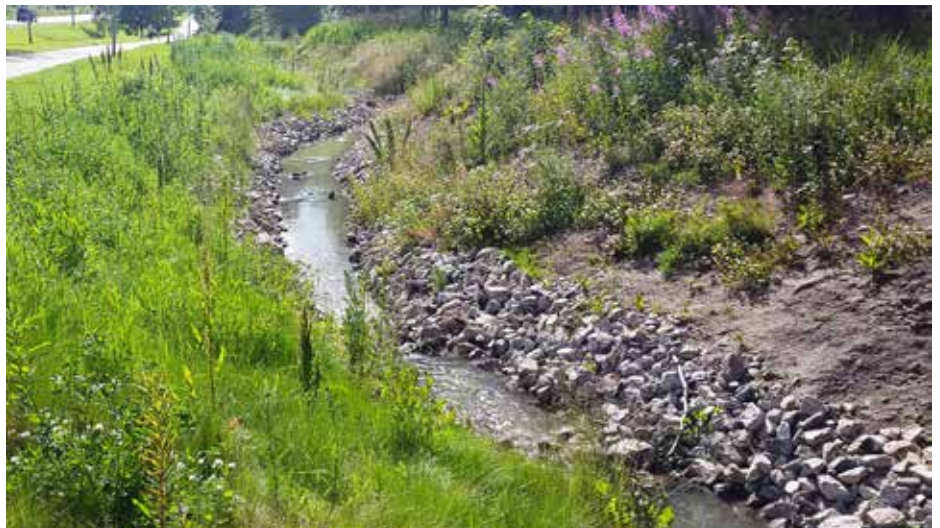
Lahdessa sijaitseva tiealueen hulevesien laskeutusaltaan jälkeinen avouoma kesällä 2017 vuoden kuluttua rakentamisestaan.
