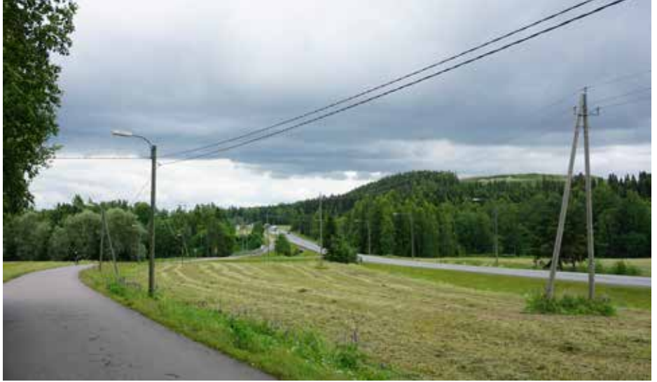
Kehätie tulee kulkemaan suurelta osin neitseellisessä maastossa. Kuvassa Okeroisten eritasoliittymän tuleva sijainti.
