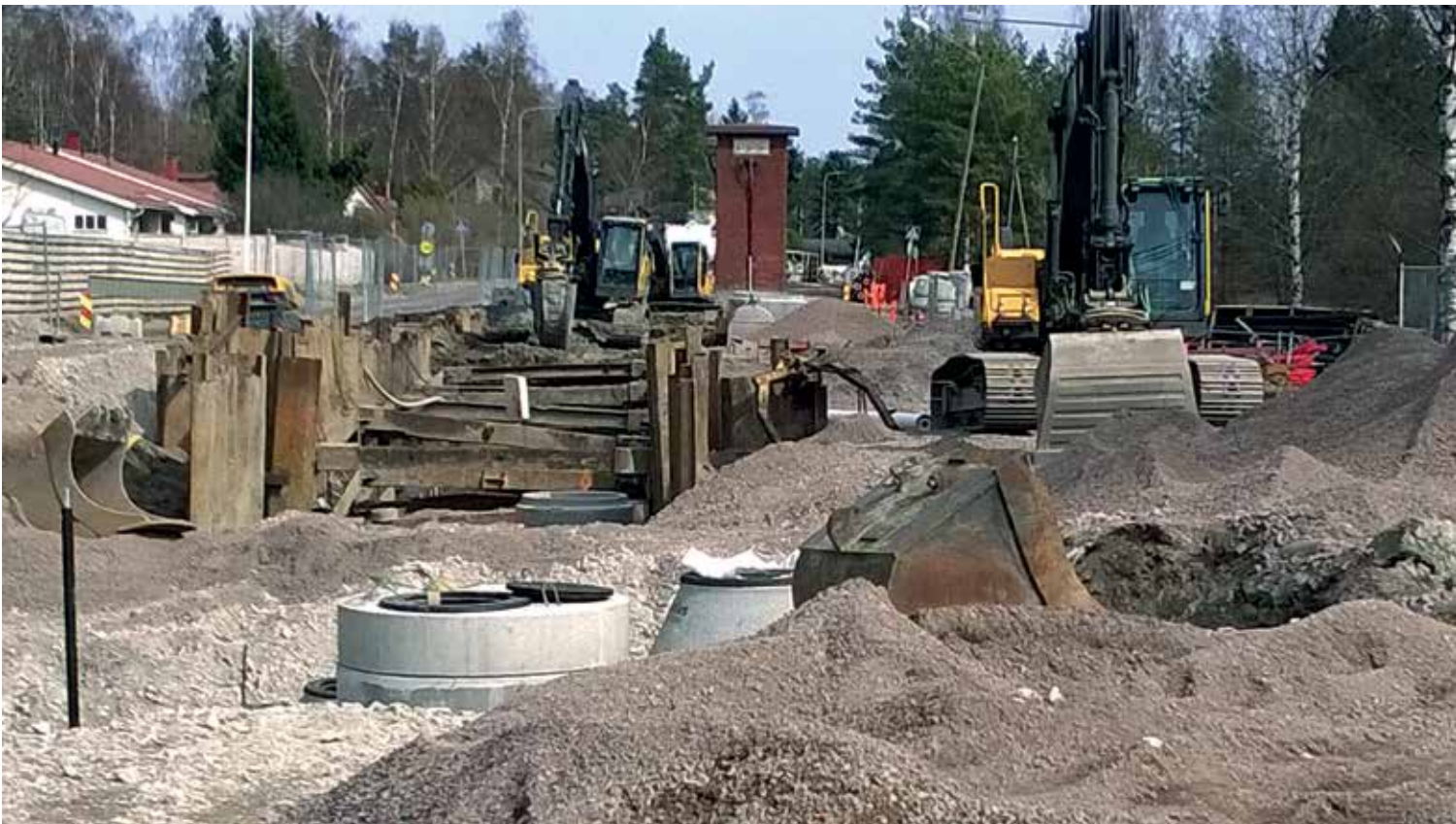
Vesihuollon ja kadun saneeraus käynnissä Laakso lahde tiellä Espoossa.
