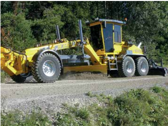
Kulutuskerroksen muokkausta tiehöylällä ja lanalla.
