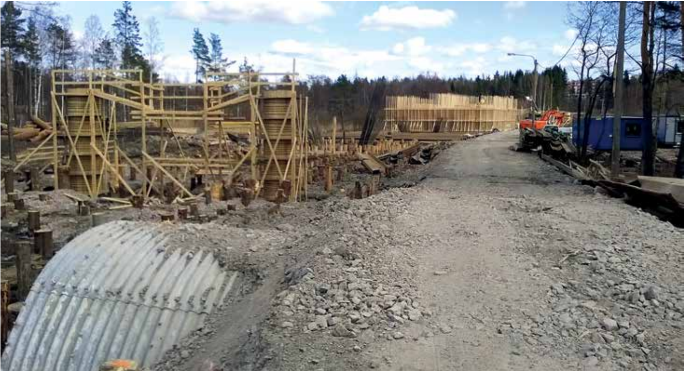
Lähes 400 metriä pitkän Suomenlahdentien sillan telinetöitä. Pehmeä maaperä edellyttää telineiden paalutusta.
