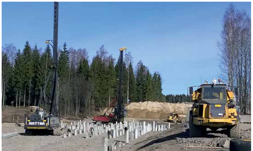
Paalulaatan tekoa uuden pääkadun Turveradantien alla.
