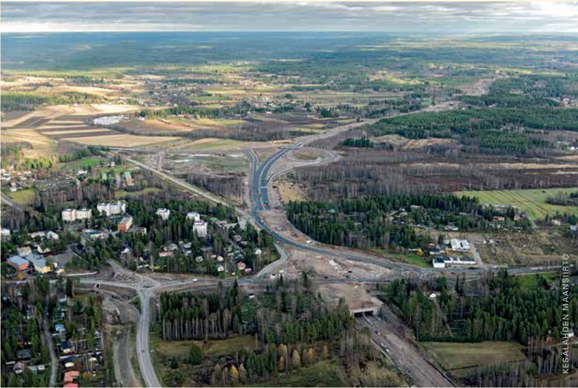
Haminan ohikulkutie valmistuu vuoden 2014 lopulla. Ensimmäisen vaiheen rakentaa Kesälahden Maansiirron ja YIT Rakennuksen työyhteisliittymä.
