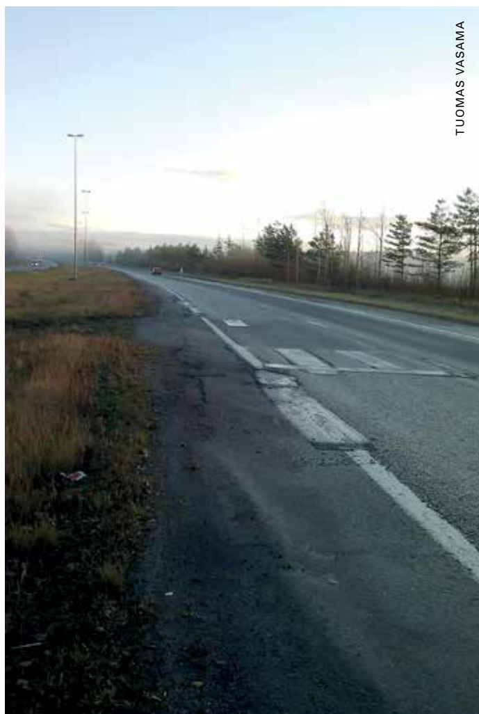
Tieverkon ylläpidossa yhä isompi rooli on paikkauksilla ja muilla täsmätoimenpiteillä.
