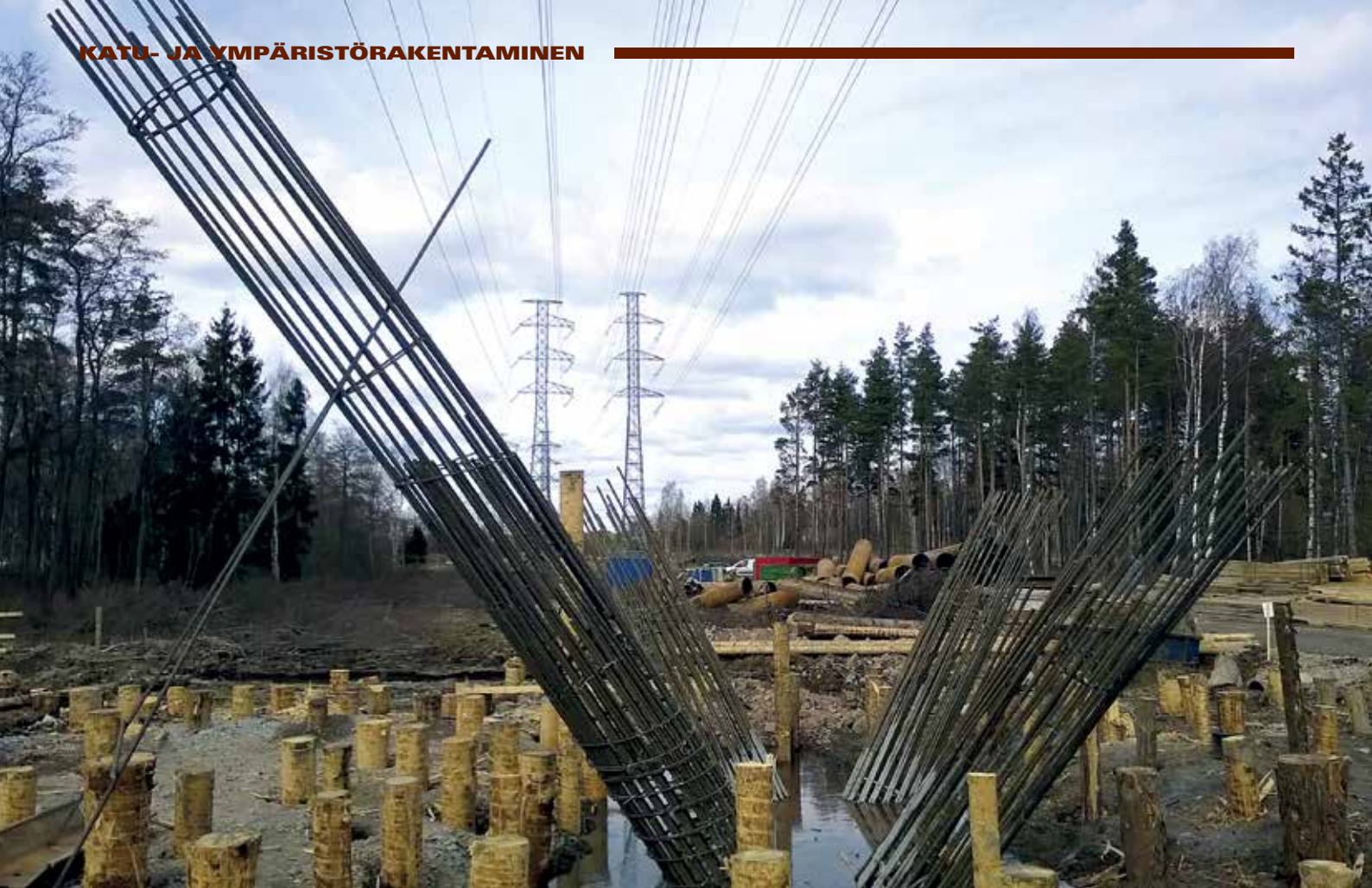
Suomenlahdentien sillan erikoislaatuisia pilareita. Voimajohdot asettavat omat haasteensa toteutukselle.
