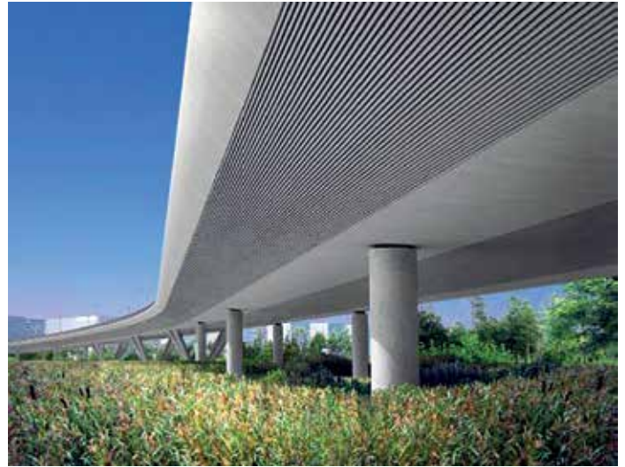
Suomenlahdentien uusi silta ylittää arvokkaan lintukosteikon.
