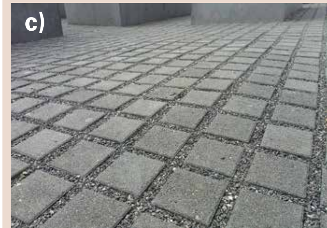
Vettä läpäisevien päällysteiden materiaaleja: a) Avoin asfaltti (AA), poralieriöitä; b) Läpäisevä betoni (LB) Rig-tutkimuksissa sadetusyksikön alla; c) Betonikivipinta, jossa saumoissa vettä hyvin läpäisevää kiviainesta.
