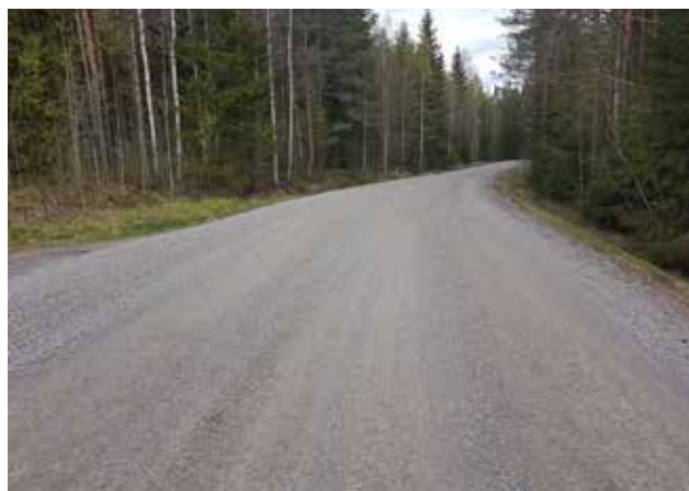
Kuva 4. Valkeejärvi 14307, Jämsä. Tie on kunnostettu sora- tieksi syksyllä 2018. Tien liikennemäärä: KVL: 60, KVL Raskas: 2. Kuva 13.5.2019
