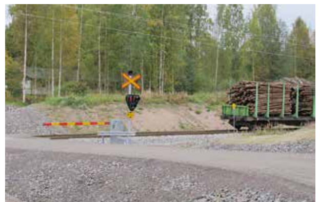
Tämä tasoristeys on jo varustettu puolipuumilaitoksella, mikä yksityisteillä ei ole kovin yleistä.
