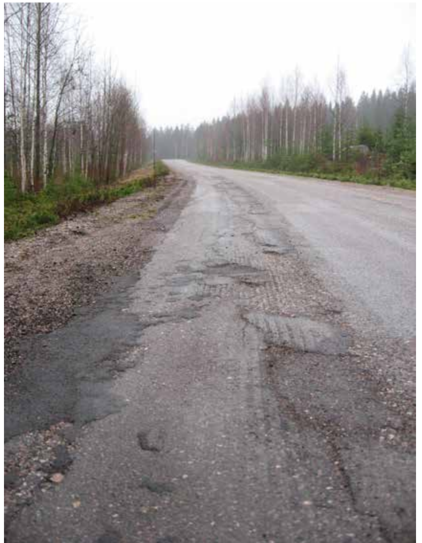
Kuva 1. Päällysteen paikkauksen haasteita.
