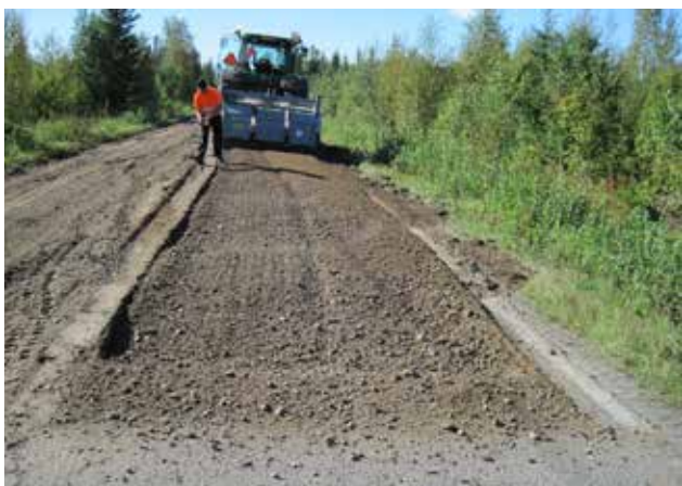
Kuva 3. Kivijyrsimen käyttöä muutettaessa päällystettyä tietä sora- tieksi.
