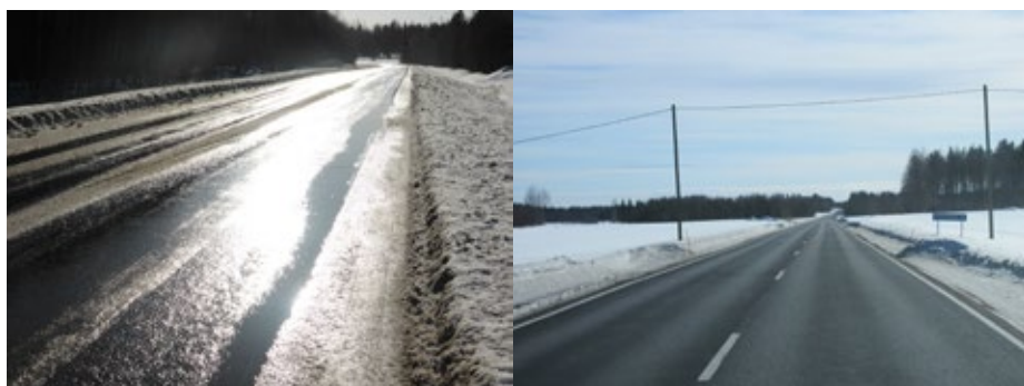
Kuva 2. Rovaniemen PEHKO-alueen tiestä maaliskuussa 2015 (vasen) ja 2017 (oikea). Lumivalien madaltaminen tammikuun lopussa ja sohjo-ojen teko maaliskuun alussa estävät jääpolanteen syntymisen tien reunaan sekä lumesta sulavan veden imeytymiseen päällysteen alle. Tuloksena merkittävät säästöt päällysteiden vuosikustannuksissa ja huomattavasti turvallisemmat tiet.
