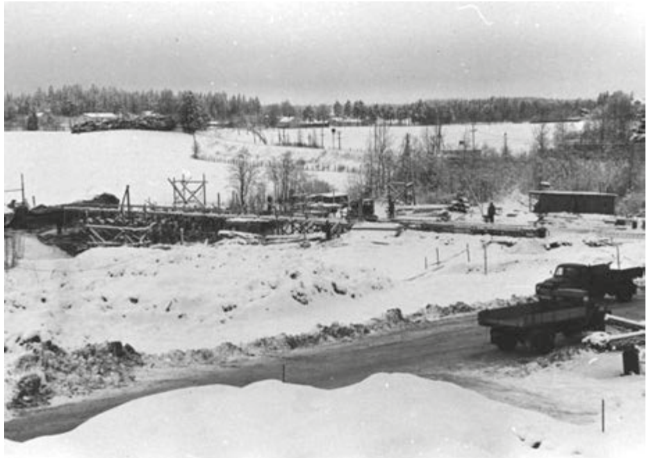
Ahjontietä rakennetaan Keravalla talvella 1960. Etualalla siltatyömaa, kuorma-autoja ja rakennusparakki.
