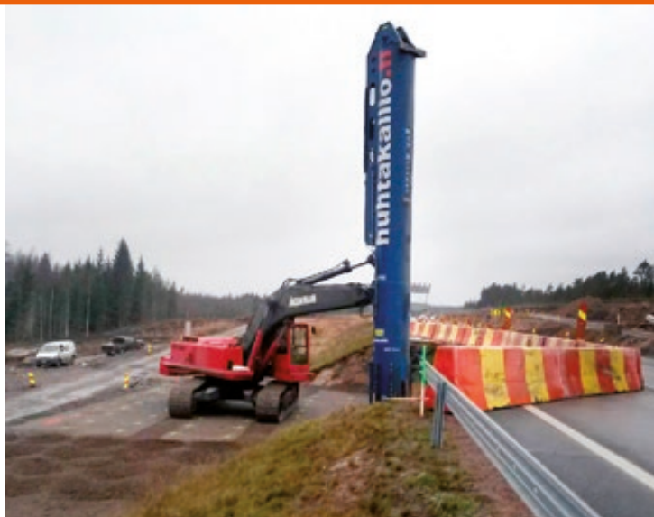
Pudotustiivistys soveltuu mm. sillan välitukien pohjan vahvistamiseen.
