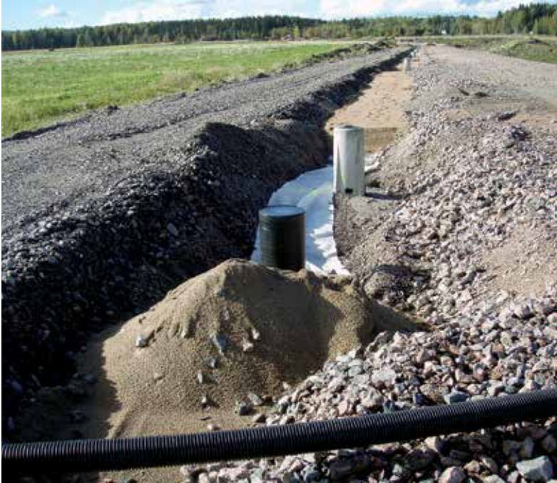
Tikkurilantie ja välikaistan suodatuspainanteet rakenteilla syksyllä 2012.
