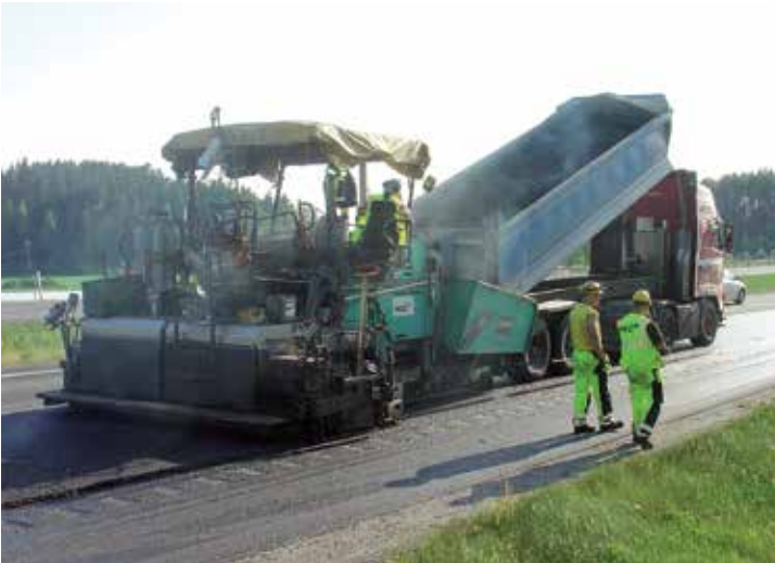
Päällysteen pintalämpötila mitattiin levittimeen asennetulla lämpökameralla.
