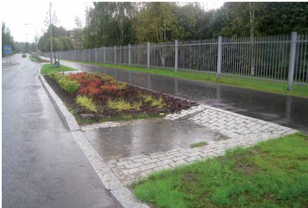
Meiramitiellä vesi lammikoituu kivettyyn painanteeseen ja johtuu edelleen kasvillisuuden verhoamalle suodatusalueelle.
