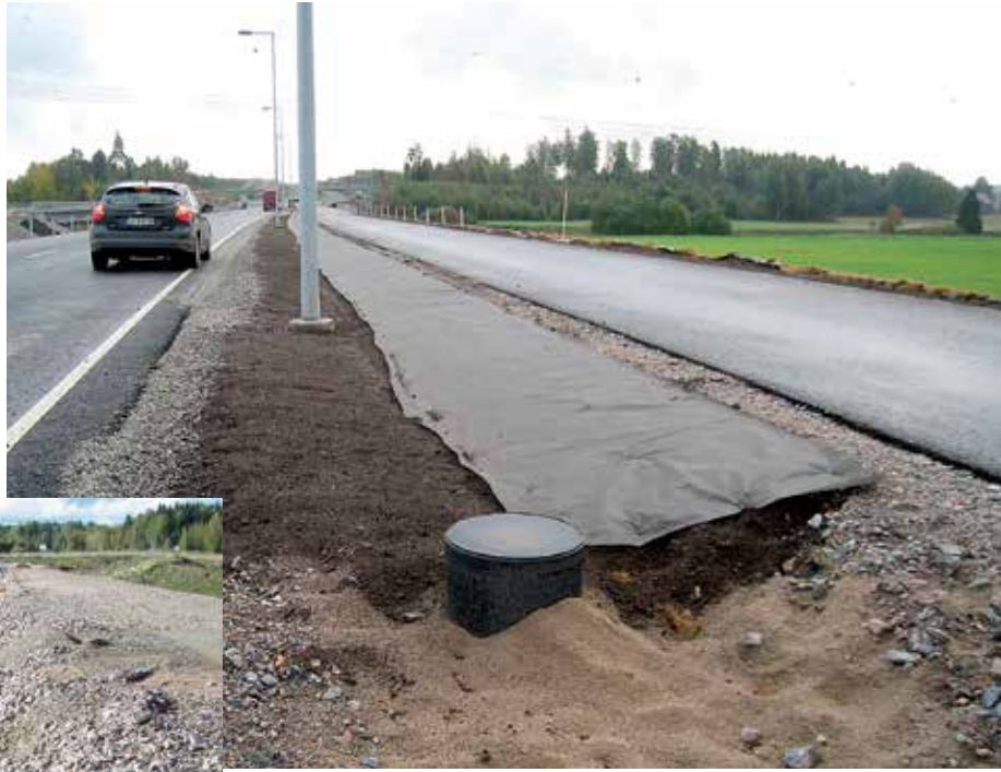
Tikkurilantien välikaistan suodatuspainanne valmiina kylvöä ja pensaiden istutusta varten.
