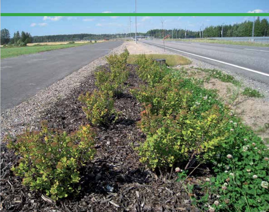
Tikkurilantien suodatusrakenteet vaihtelevat jaksoittain biosuodatukselta hiekkasuodatukseseen.
