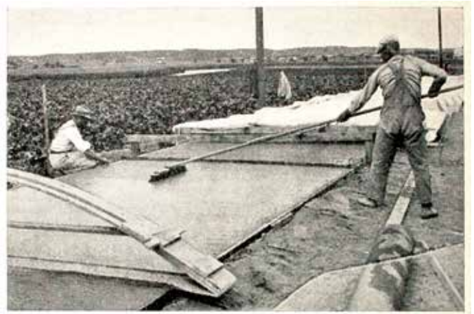
Betonipäällysteen pinnan sivelyä jouhiharjalla.
