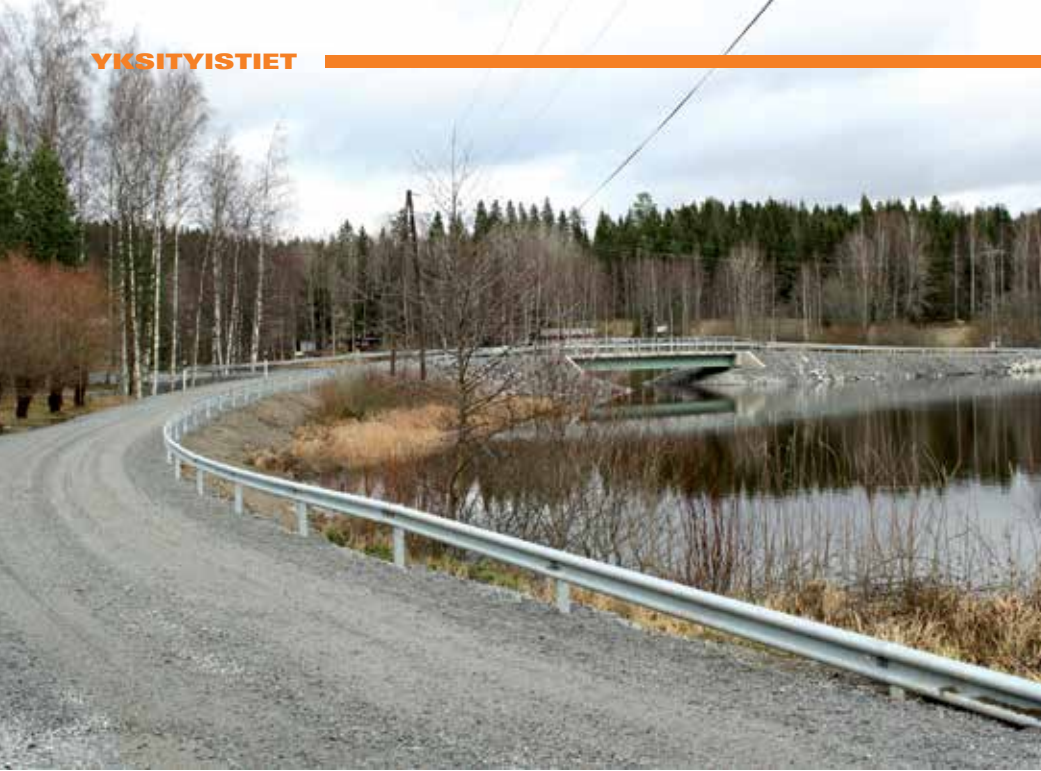
Etualalla näkyvää tieosuutta korotettiin tulvivan veden estämiseksi. Uudet kaiteet vastaavat nykyisiä vaatimuksia.
