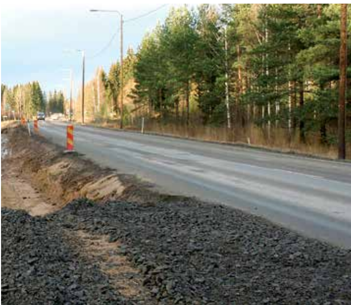
Tien kunto ennen korjaustoimenpiteitä.
