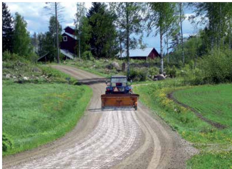
Yksityisteillä riittää yleensä yksi levityskerta tien keskelle. Suola peitetään lanauksella, jolloin se samalla leviää koko tien leveydelle.
