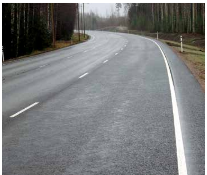
Tien kunto ennen korjaustoimenpiteiden jälkeen.
