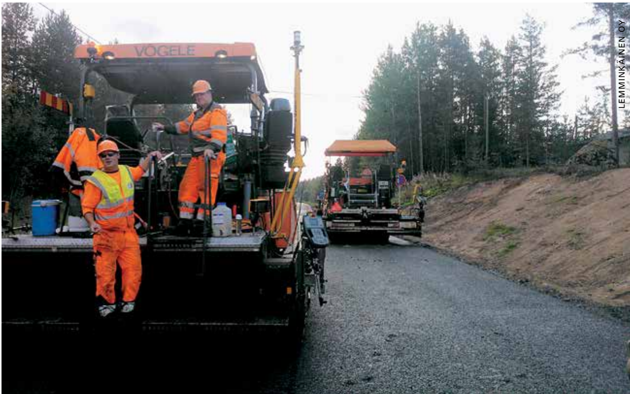
Mallipohjaisen ABK-kerroksen levityksessä käytettiin uusinta koneohjausteknologiaa.
