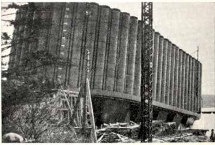
Vähän-Beltin sillan rautabetoninen uppoarkku.
