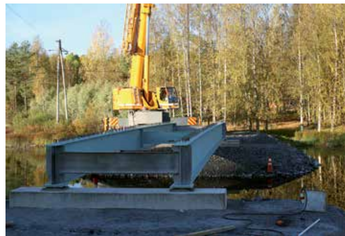
Teräsrakenne nostettiin paikalleen neljän kumilaakerilevyn päälle yhtenä kappaleena valmiiksi pintakäsittelynä.
