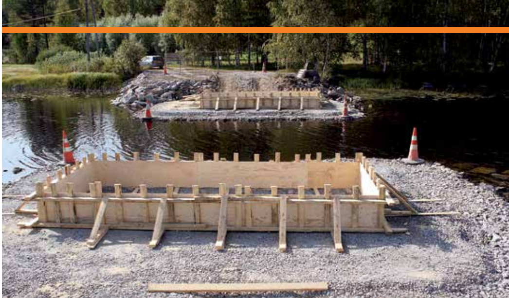
Anturalaudoitukset odottavat valamista.
