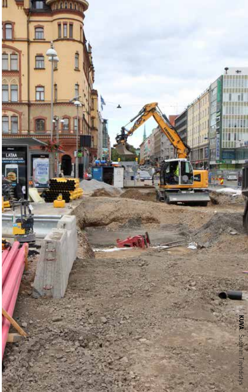
Rakennustyömaalla riittää huomioitavaa. Kuva Tampereen raitiotierakennustyömaalta.
