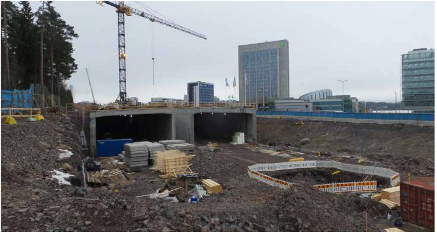
Kehä I leikataan 5–7 metriä aiempaa tasausta alemmas massiivisen betonitunnelin suojaan.
