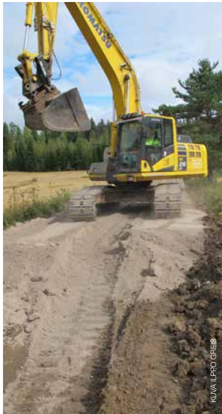
Massiivituhkakerros tiivistetään jakavaksi kerrokseksi ja peitetään kulutuskerroksella.
