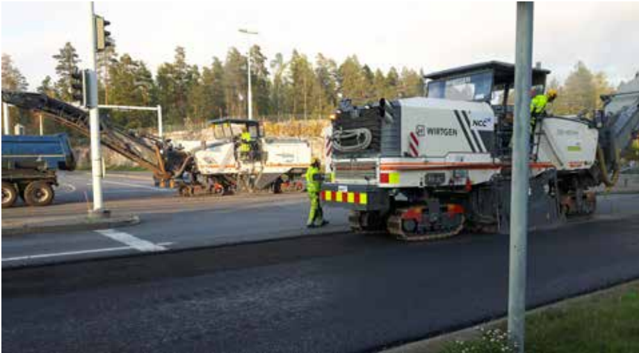
Vanhaa asfalttia poistetaan jyrsimällä ja se voidaan käyttää uudelleen. Vanhan päällysteen materiaali tutkitaan ja kovan kiven rouheet varastoidaan erikseen.
