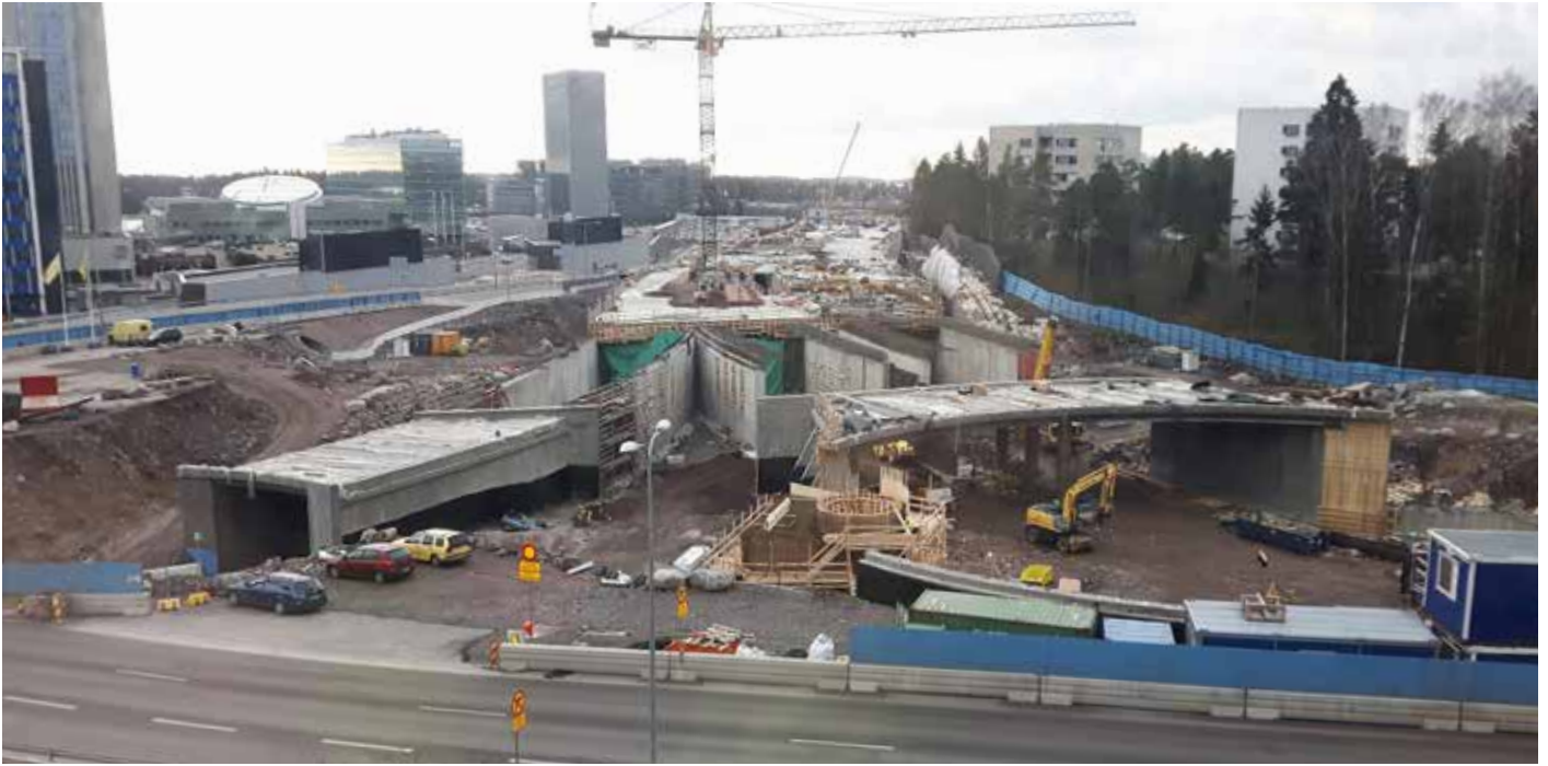
Pohjoispäässä tunneli haarautuu ja liittyy Otasolmun kiertoratasoliittymän siltoihin. Tammikuussa 2018 tunnelin kannesta puuttui vielä joitakin kymmeniä metrejä.
