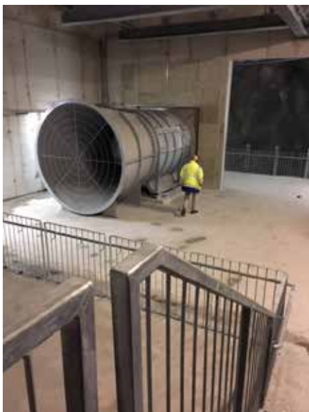
Valvomosta käsin koekäytettävä savunpoistopuhallin Hanasaaren kuilun savunpoistokammiossa.
