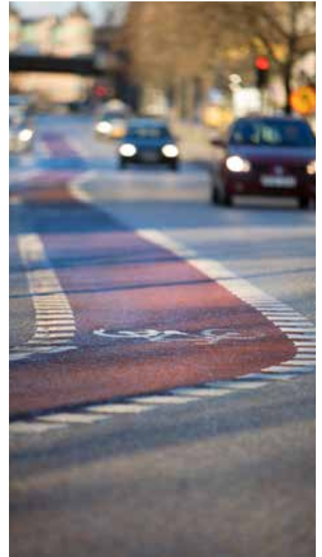
Ohutpinta ViacoGrip kestää hyvin liikenteen kulutusta tavallista rakeisemman päällystetä massan ja siinä käytettävän kiviaineksen vuoksi. Se on liikenteelle turvallinen, sillä rakeinen pinta antaa hyvän pidon sateellakin. Pinta on hiljainen ja sitä voi myös värjätä.
