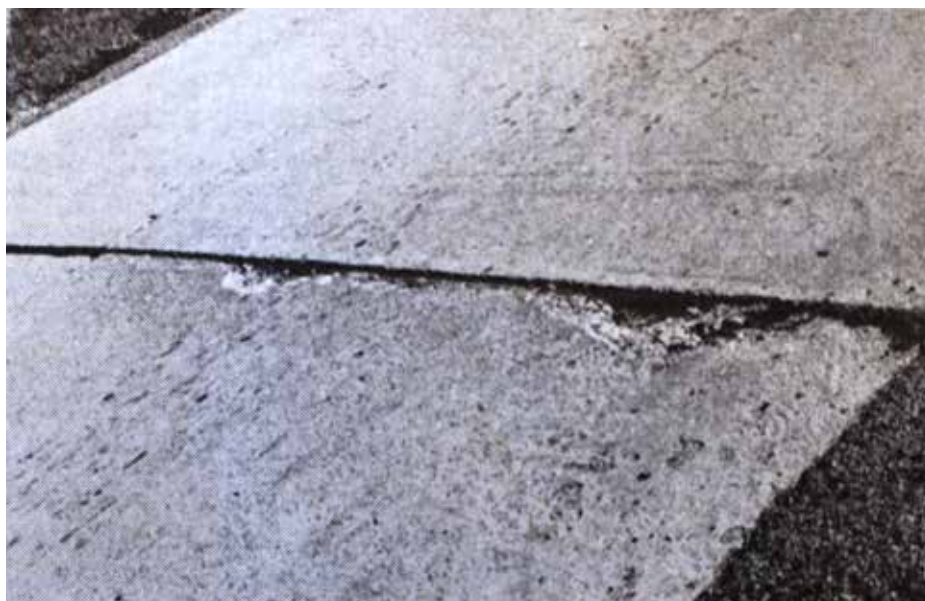
Sementin säästämiseksi ja laatan vahvuuden pienentämiseksi on menty liian pitkälle.
