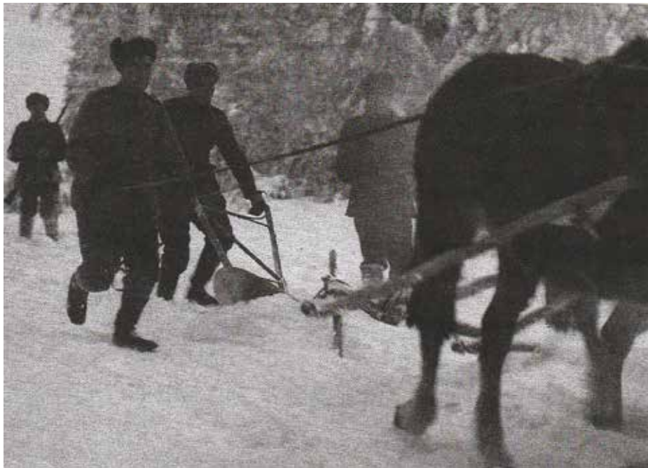
Polanteen poistoa peltoauralla Röhön tiellä. SA-kuva
