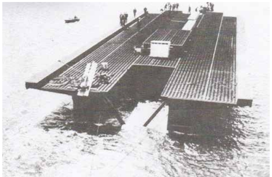
Moottoritiesilta ui paikalleen 1960-luvulla.
