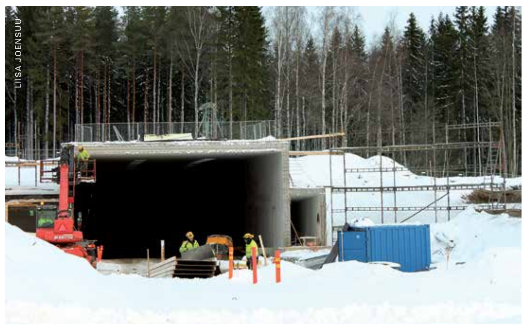
Avoleikkauksien kohdalle rakennettiin betonitunnelit. Paloheinän betonitunnelin suuaukkoa rakennettiin tammikuussa 2015.
