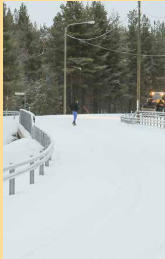
Tien parantamisen yhteydessä korjattiin myös Nellimjoen silta vajaalla miljoonalla eurolla.
