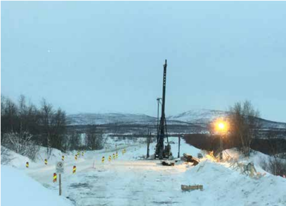
Peeran palsasiltatyömaa paalutusvaiheessa joulukuussa 2017. Sillalle tulee pituutta 92,6 m ja sen jatkeena on paalulaattarakennetta 58,1 m. Sillan kohdalla vanhan tien öljysoran paksuus oli yli 1,8 m.
