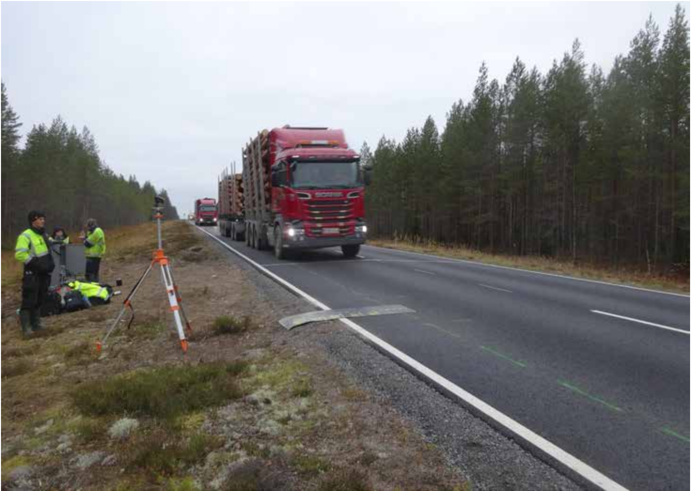
Kuva 1. HCT-rekkojen kuormituskokeet meneillään Karstulan tutkimuskohteella Kt 77:llä lokakuussa 2016.
