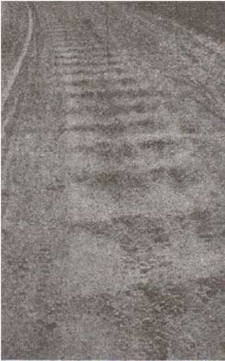
Poikittainen kouruuntuminen eli nimismiehen kihara on soratien perusviitsaus, joka lannistetaan tiehöylällä. Kuva teoksesta Suomen teiden historia II.
