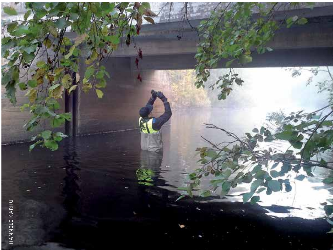
Koko silta ja siltapaikka tarkastetaan aina rakenneosittain. Kaikki rakenneosat sekä erityisesti vauriokohdat valokuvataan. Siltatarkastusta on tekemässä Veikko Heikkinen.
