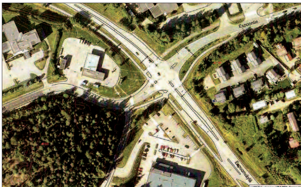
Espoonväylän, Espoontien ja Mikkälänkallion liittymä vuonna 2009.
