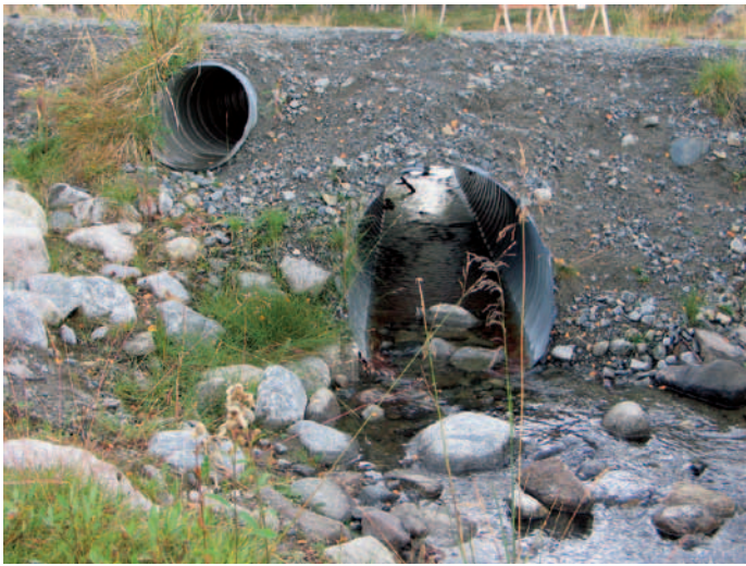
Kuivatuksen kunnostus on liki kaikissa parantamisbankkeissa ykkösasia. Kuvan tapauksessa ammattitaitoinen suunnittelija on katsonut tarpeelliseksi tavallisen rummun lisäksi tulvarummun.
