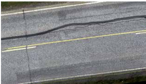
Keilauksen tuloksena saadaan ortokuvia, joista voidaan havaita päällystevaurioita ilman kenttämittauksia.
