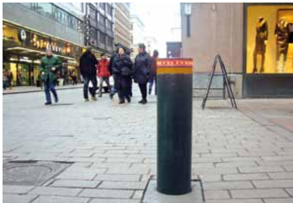
Automaattipollarit ovat normaalisti yläasennossa estäen pääsyn kadulle, mutta laskeutuvat alas jos autolla on kulkulupa.
