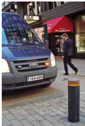
Luvalliset autot tunnistetaan automaattisesti käyttäen kehittyneitä tunnistusmetodeita kuten RFID-tageja ja mobiilitunnistusta.
