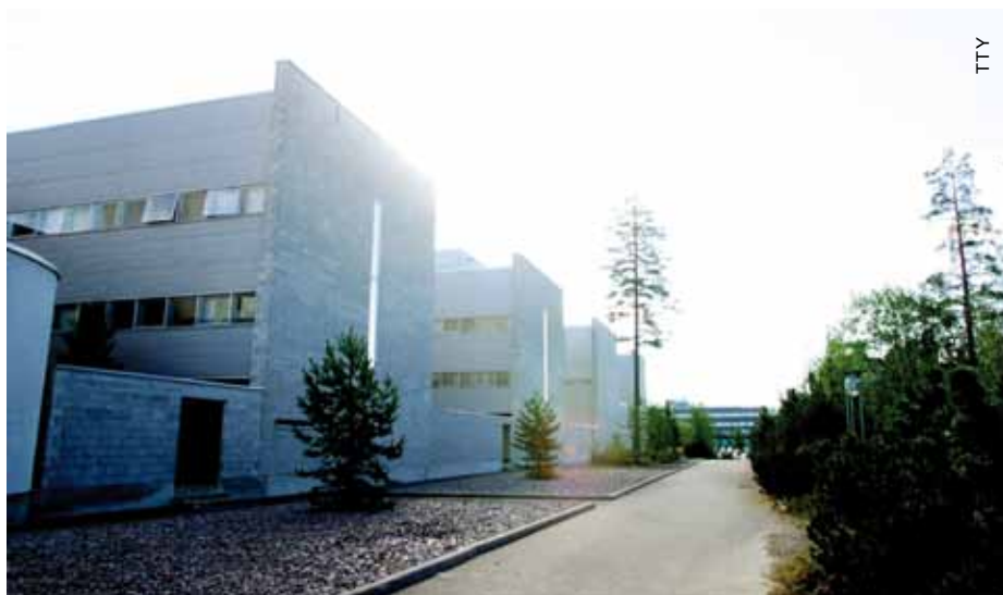
Verne on verkottunut ulkoisten toimijoiden lisäksi myös TTY:n sisäisesti, esimerkiksi rakennetun ympäristön tiedekunnan eri yksiköiden kanssa. Vernen oma päämaja sijaitsee TTY:n Festia-talossa.
