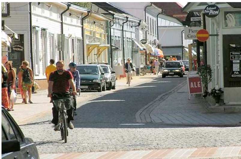
Kuninkaan-kadulta on poistettu ajoradan reunakivet ja väylä on rakennettu kevytliikennepainotteiseksi. Vasemmanpuoleisessa kuvassa on aikaisempi ratkaisu.
