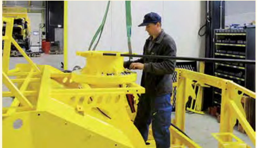
Asentaja Asso Seiler kääntökehän asennustyössä.
