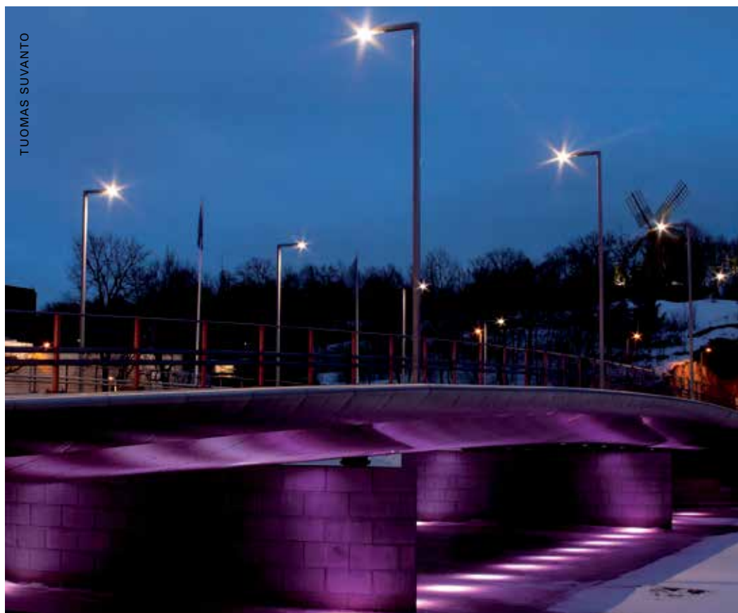
Joen liike heijastuu Myllysillan pinnassa. Valaisimet on integroitu näkymättömästi sillan alapintaan.
