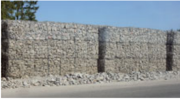
Melusuojuuksia on tehty paljon. Kivikorirakenteen lisäksi on maavalleja. Silloilla on betonisuoja ja kolme metriä korkea pleksilasi.
