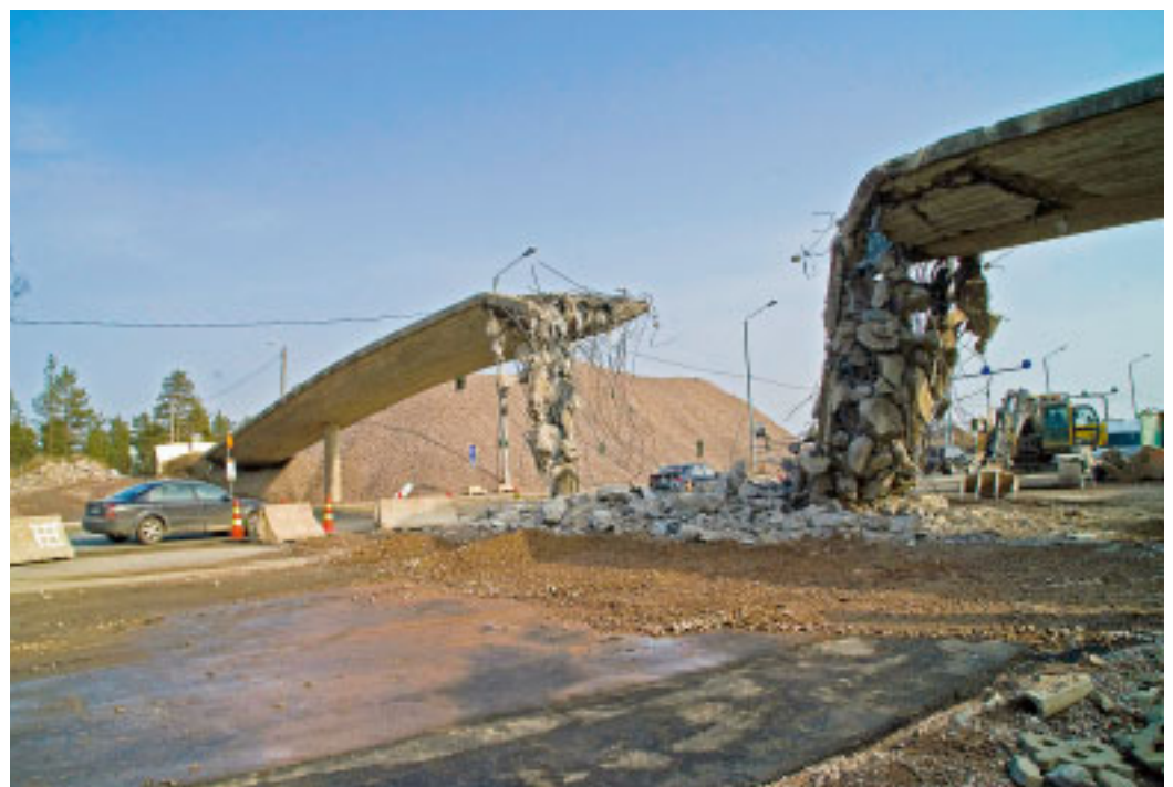
Vanhaa kevyen liikenteen siltaa puretaan Hakamäentiellä.
