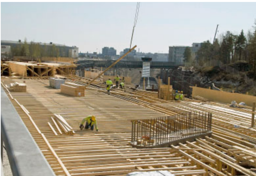
Rantaradan ylittävän sillan työmaa vauhdissa keväällä 2008.
