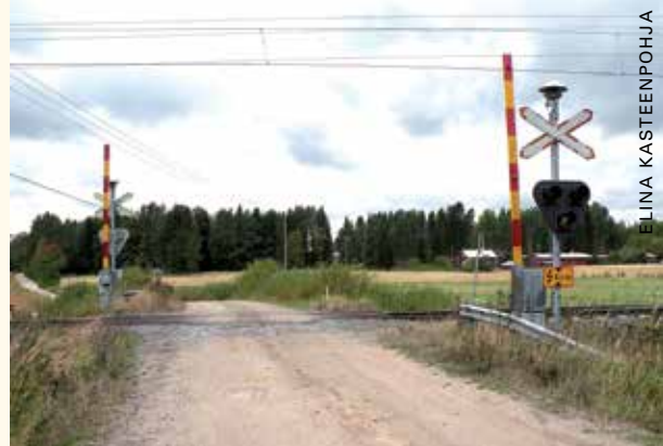
Rautatien tasoristeysmerkit, liikennevalot ja sulku- ja varoituslaitteet asettaa ja kunnossapitää radanpitäjä. Muiden merkkien asettaminen ja kunnossapito kuuluu yksityistien tienpitäjälle.
