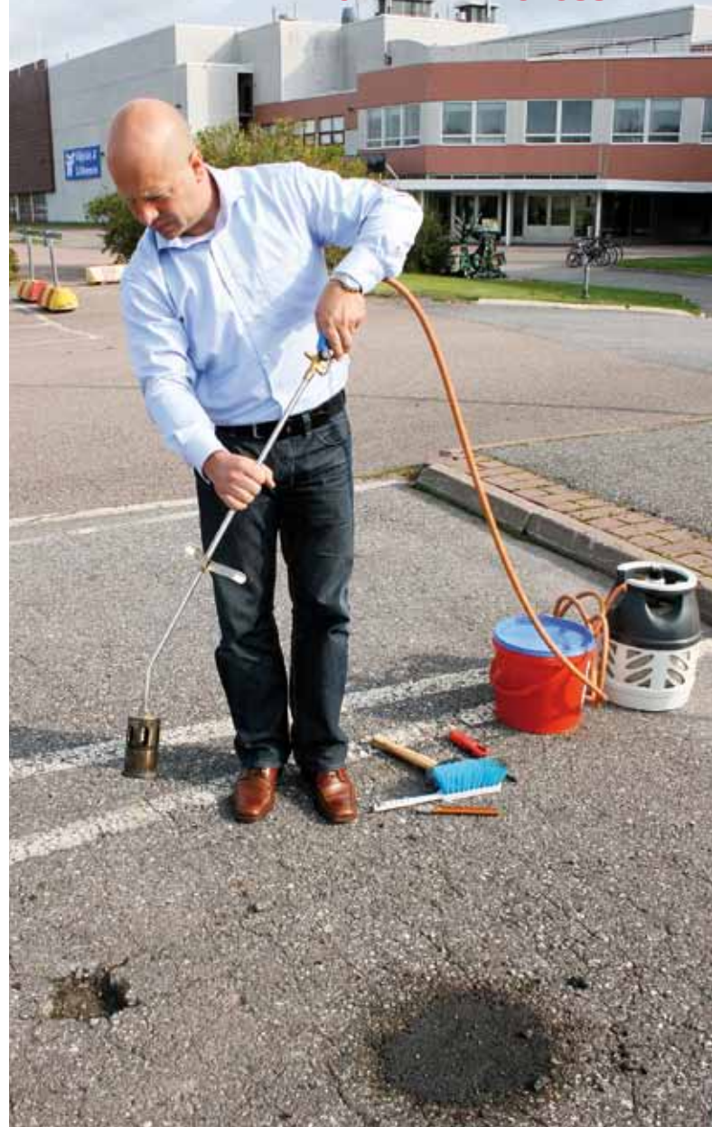
Näyttelyyn liittyi tällä kertaa myös toimintaa ulkotiloissa. Martin Fuchs Hard-eco Asphalt Fluid GmbH:stä esitteli pienten vaurioiden korjaukseen soveltuvaa lämpömuovautuvaa valuasfalttia.
