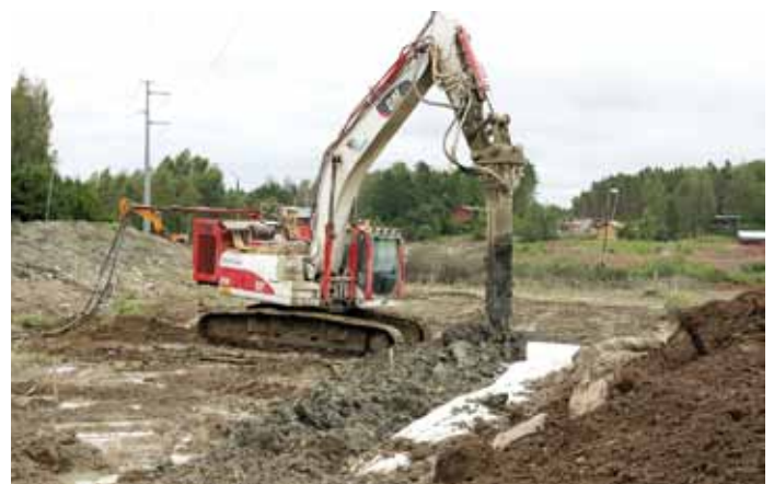
Stabilointia tarvitaan, jotta savinen maa saa riittävästi kantavuutta.
