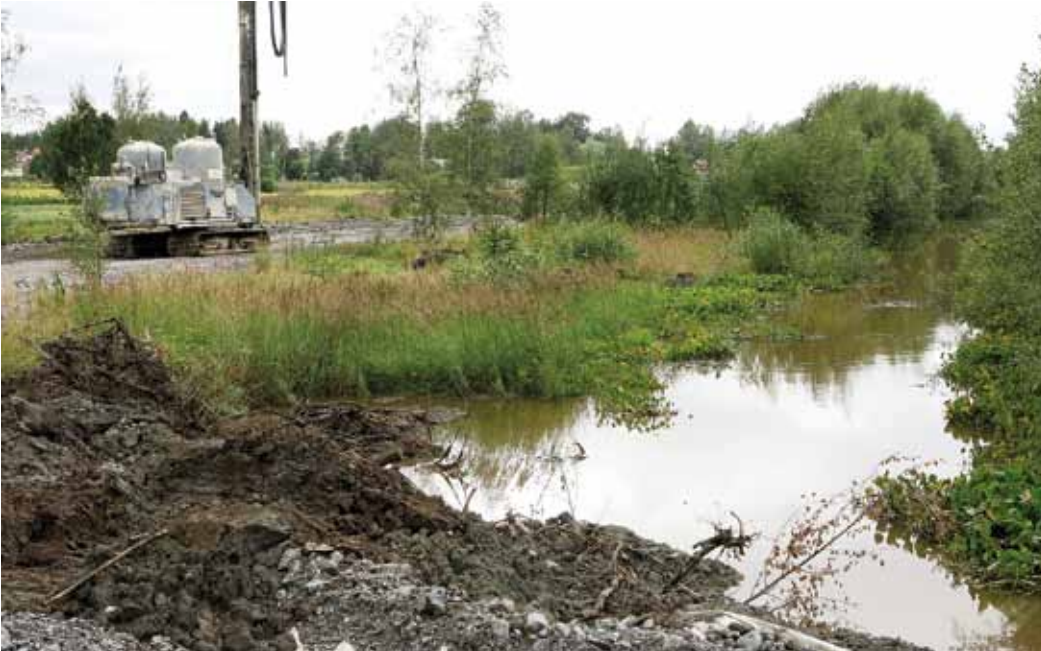
Vesi makaa Pohjanmaalla. Runsaat sateet aiheuttavat ongelmia myös tietyömaalla.
