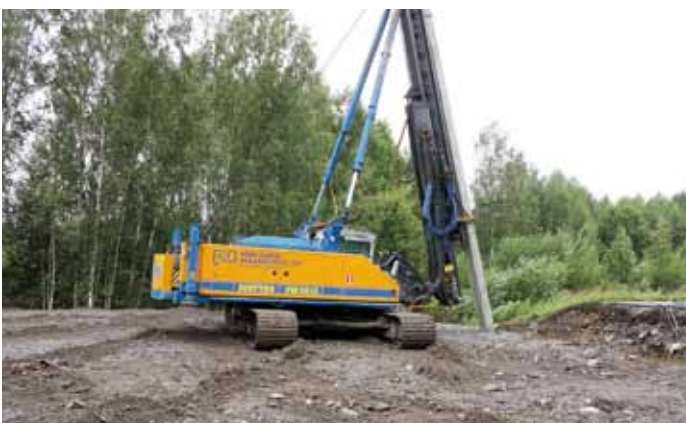
Paalutustyöt käynnissä Karperön sillan paalulaatan alueella.
