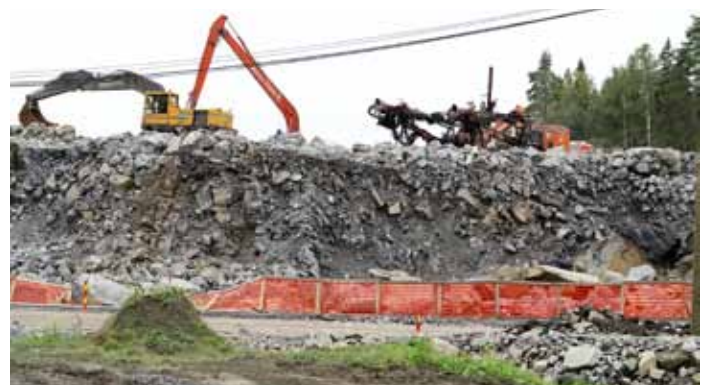
Karperössä joudutaan tekemään runsaasti louhinta- ja räjäytystöitä.
