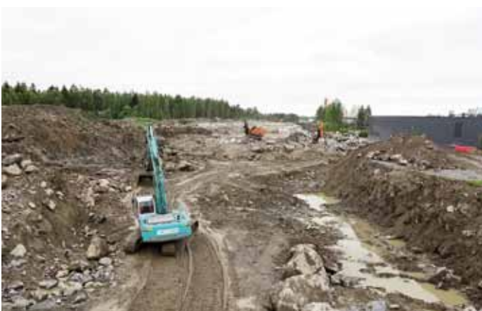
Leikkaustöitä Välitien kohdalla.
