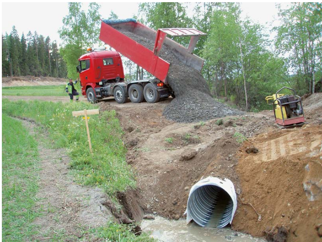
Uuden rumpun asennusta.
